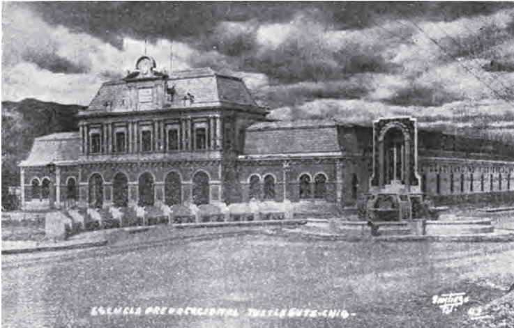
Escuela Industrial, conocida como El Edificio, después llamada Prevo-cacional. Foto tomada del libro Monografía del Progreso Material de Tuxtla durante el Gobierno del doctor Rafael P. Gamboa 1944.
