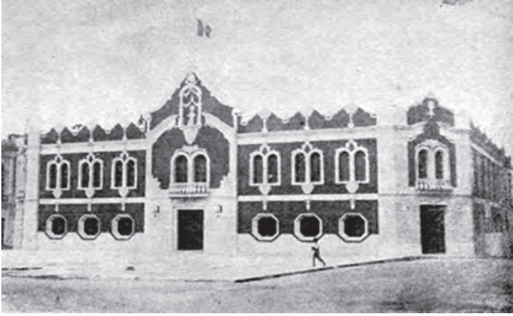
Palacio federal en la década de 1950 donde se encontraban entre otras oficinas la de Correos y Telégrafos. Foto tomada de la Monografía del progreso material de Tuxtla durante el gobierno del Dr. Rafael P. Gamboa 1944.
