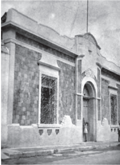
Edificio que albergó a los Juzgados Civil y Penal en la década de 1940. Se ubicaba en 1ª. Sur entre 2ª y 3ª Oriente.
