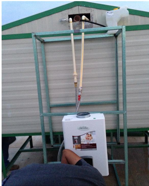
**Figura 50.**Instalación del calentador comercial
