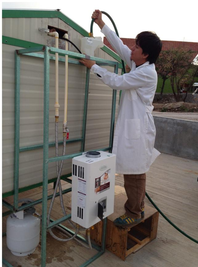
**Figura 51.**Instalación del sistema de combustión de biogás
