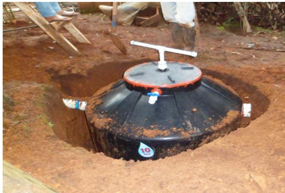
**Figura 44.** Instalación del Biodigestor
