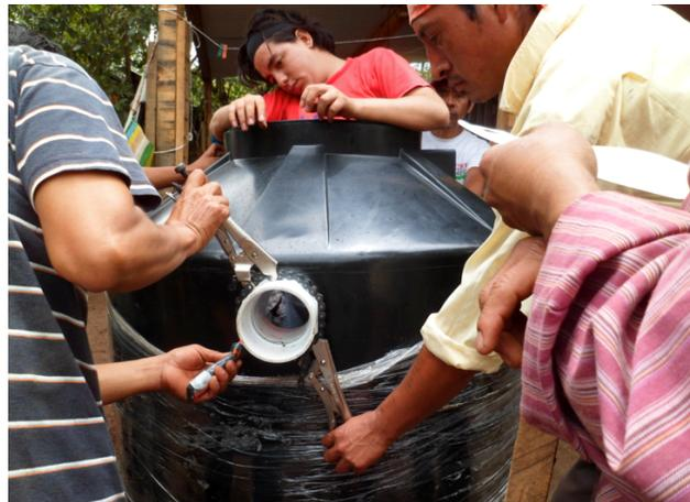
**Figura 36.** Ensamble de los adaptadores roscables
