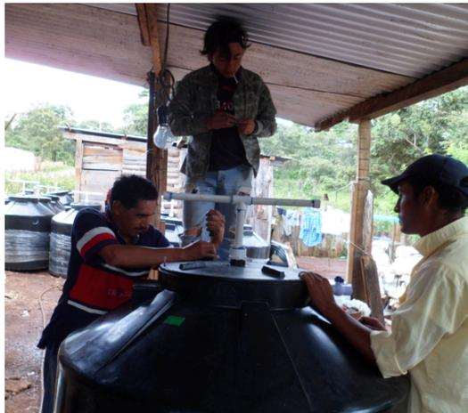
**Figura 43.** Atornillado de la tapa del biodigestor
