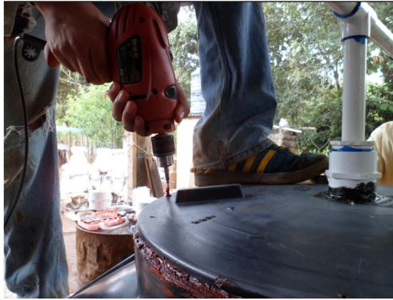
**Figura 42.** Sellado de la tapa del biodigestor
