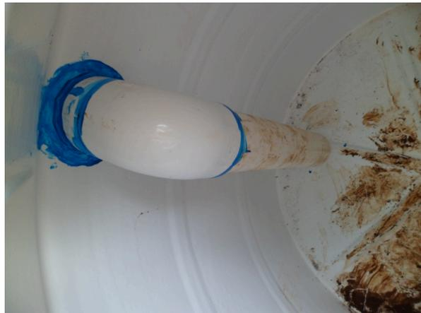
**Figura 37.** Ensamble de las tuberías de entrada y salida del biodigestor
