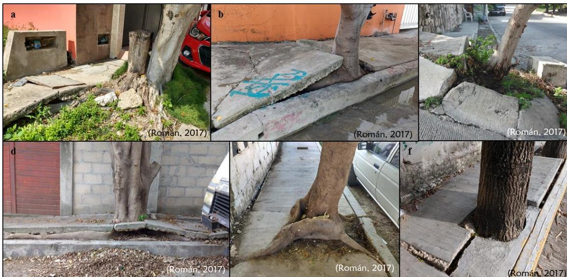
Figura 28. Daños a banquetas: a) daños a líneas hidráulicas, b), c), d), e) y f) banquetas.
