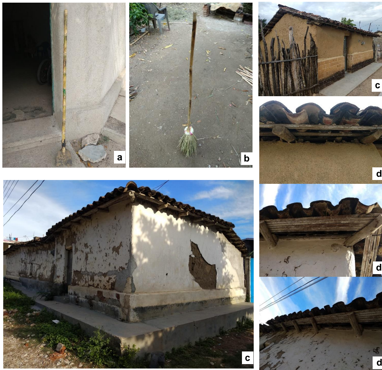
Figura 58. Diferentes formas de empleo del Guich ( Otatea fimbriata ), como en a) Herramientas agrícolas en las coas y b) utensilios domésticos en los palos de escoba de palma. Resaltando además su uso en la construcción de casas esto en el sistema bajareque. En c) Paredes, d) Cubiertas para sostener las tejas.
