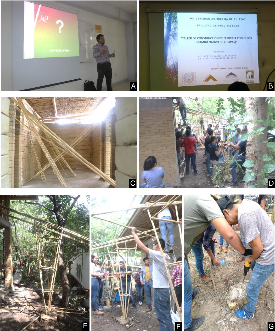
Anexo 6. Impartición del Curso – Taller de Construcción de Cubierta con Guich (Bambú nativo de Chiapas). A y B) Explicación introductoria del concepto de bambú, especies nativas, principios constructivos, cultivo y aprovechamiento. C) Varas de Guich ( Otatea fimbriata ) empleadas en el taller. D) Trabajo en equipo de los participantes en el armado de estructura y cubierta. E, F y G) Estructura ligera formada con varas de Guich ancladas sobre piedras de la zona.
