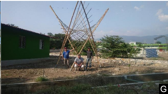
Anexo 5. Construcción de Estructura Sol y Sombra para el Jardín Nativo, en la cual se trabajaron dos especies de bambú nativas de Chiapas ( Guadua Amplexifolia y Otatea fimbriata ). A y B) Imágenes virtuales del Proyecto aceptado para la construcción. C, D y E) Proceso de habilitado de varas de Bambú y montaje de estructura. F y G) Estructura Sol y Sombra completada.
