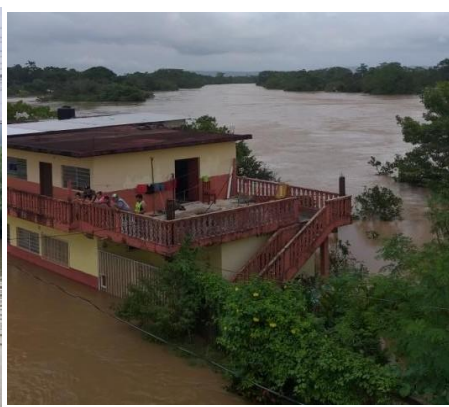
Figura 4. Inundación en la localidad de Salto de Agua Chiapas en el año de 2020. La imagen muestra parte de la calle Independencia y se puede apreciar el nivel del cauce del río Tulija. Fotografía de Mariely Cristal Lara
