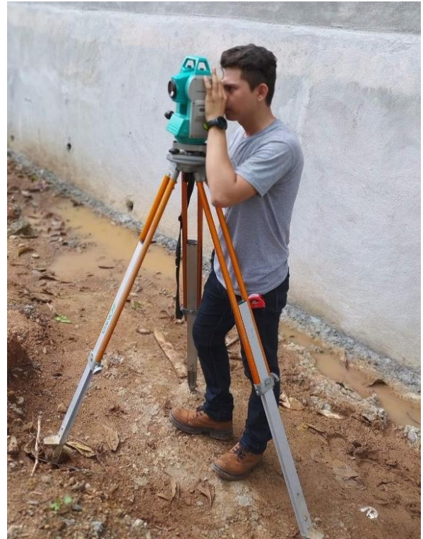
Imagen 2. Orientación de estación total para el levantamiento topográfico.
