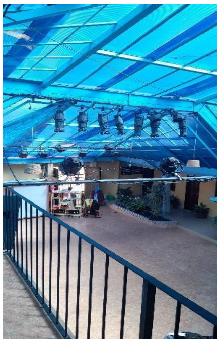
Fotografía 35. Fachada de la instalación, vista de la segunda planta.
