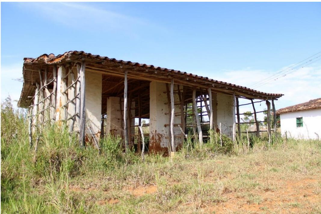
Los caneyes más antiguos utilizan técnicas de construcción con tierra cruda como la tapia pisada y tejados de cerámica, junto con estructura de madera en donde se cuelgan las cuerdas con tabaco. Algunos de los Caneyes en uso que pude encontrar habían reemplazado las tejas de barro por tejas de cinc y no tenían muros de tierra sino una estructura completa en madera.
