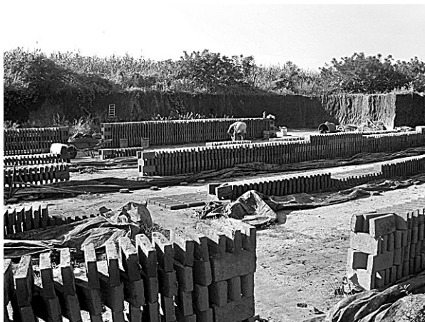
Figura 4 ■ | Ladrillera típica. Nótese el nivel del terreno natural.
