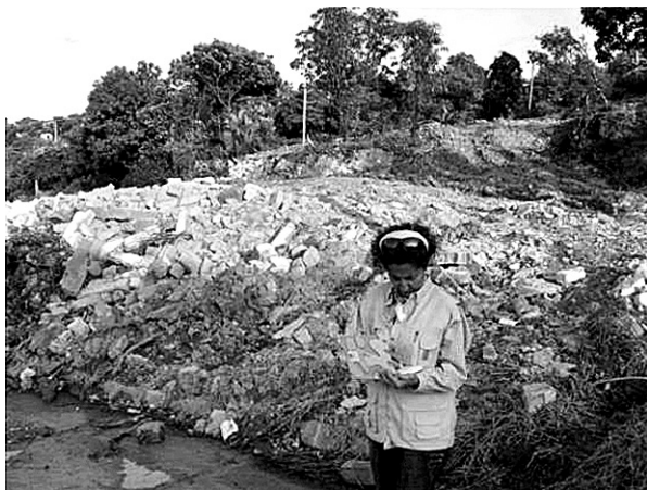
Foto 4 ■ Casas demolidas en Lomas del Oriente (sur de Tuxtla Gutiérrez) octubre 2010. Foto JP.
