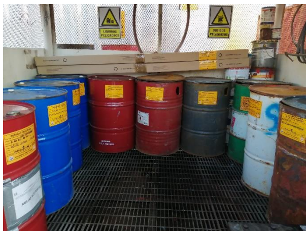
Figura 16. Este almacén contiene: aceite gastado, poliuretano, sólidos impregnados de pintura, aceite lubricante, musgos adsorbentes y sólidos impregnados de diésel.
