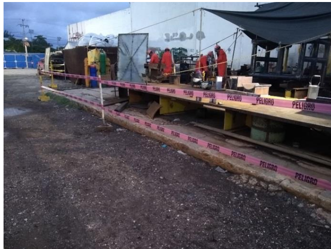
Figura 19. Las franjas rojas sirven para identificar equipo de protección contra incendios, mecanismo o materiales peligrosos.
