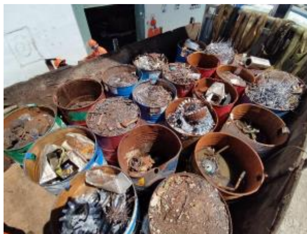
Figura 22. Inventario actual de residuos de manejo especial: tambos de escorias, colillas de soldadura, aluminio y alambres, disco de cardas, elastre, cables y fierros.
