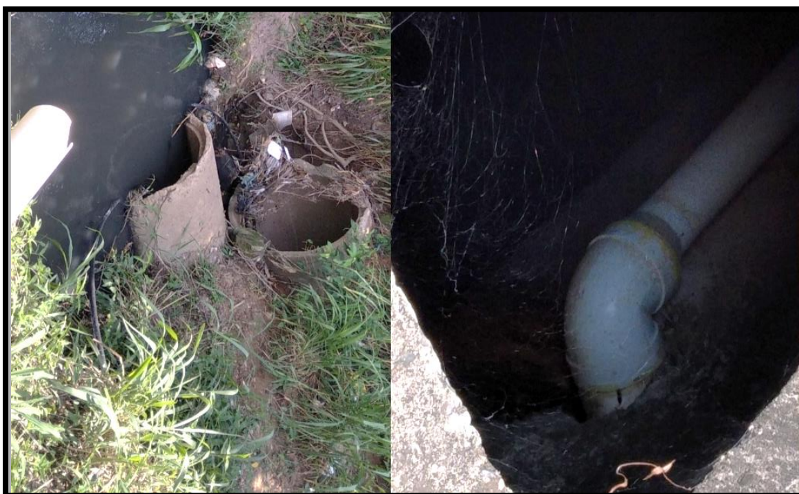
Figura 19. Conexión de drenajes al canal
