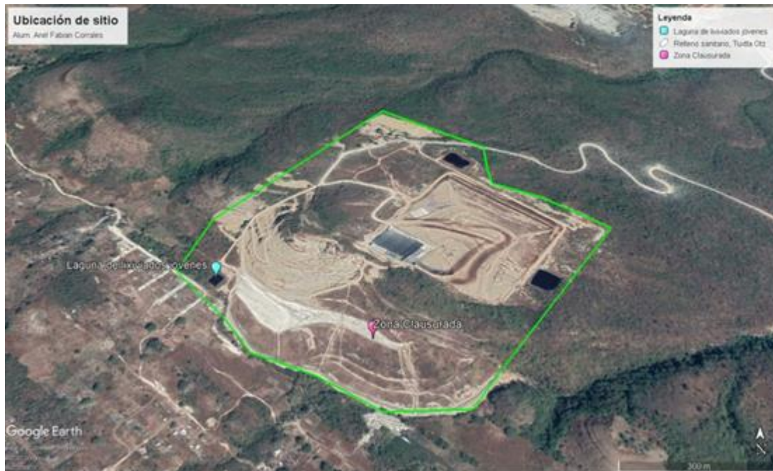
Fig. 1. Zona clausurada del relleno sanitario de Tuxtla Gutiérrez.
