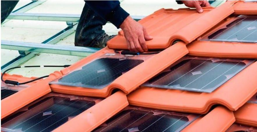
*Figura 11. Módulo fotovoltaico de tipo teja o baldosa [10].*
