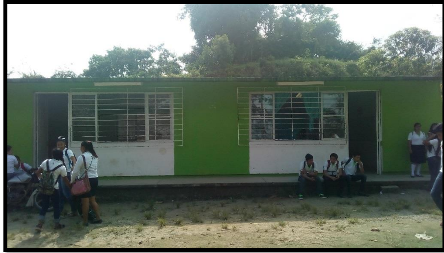
Ilustración 13. Edificio B, salones Fuente: Con base a la información obtenida
