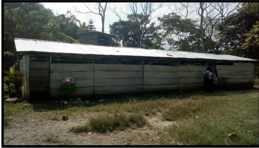
Ilustración 11. Edificio C, salón de madera Fuente: Con base a la información obtenida
