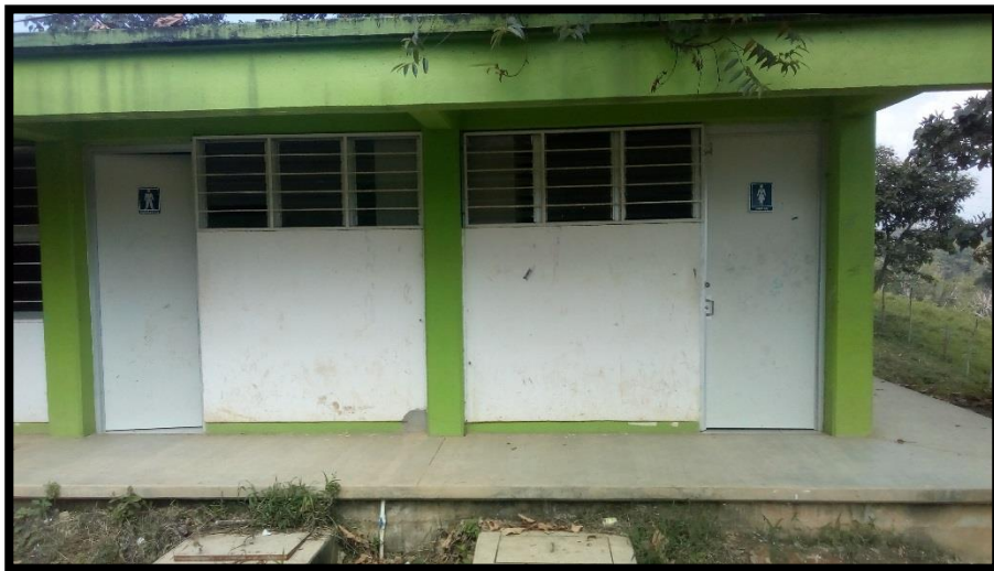
Ilustración 14. Edificio A, baños Fuente: Con base a la información obtenida
