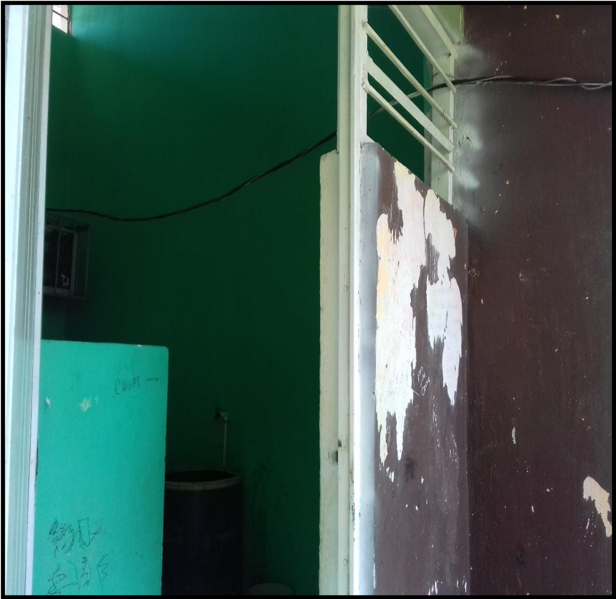
Figura. 23 Bajantes de electricidad
