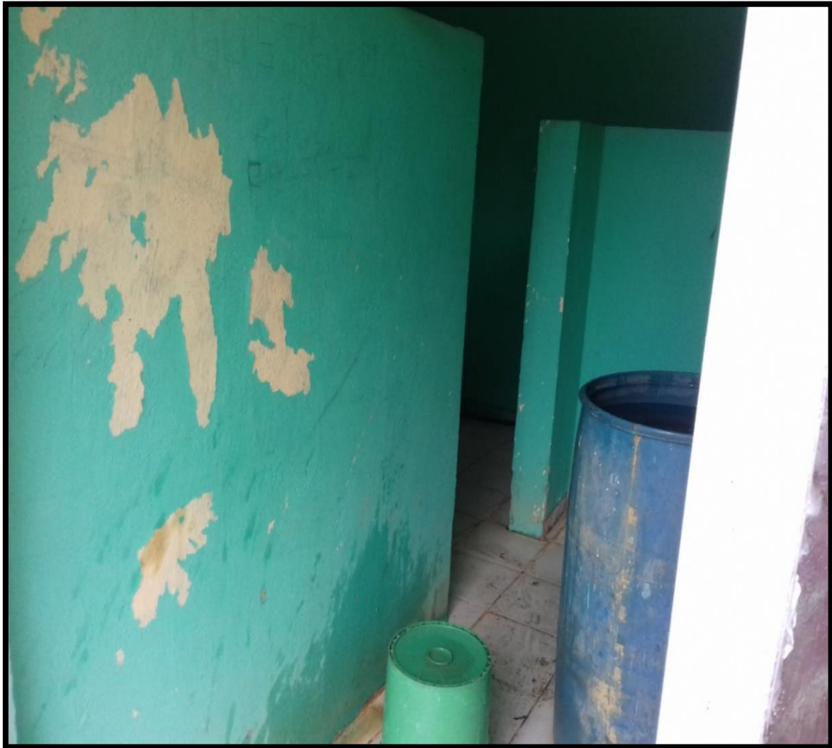
Figura. 28 Tanques de agua sin tratamiento para evitar proliferación de mosquitos
