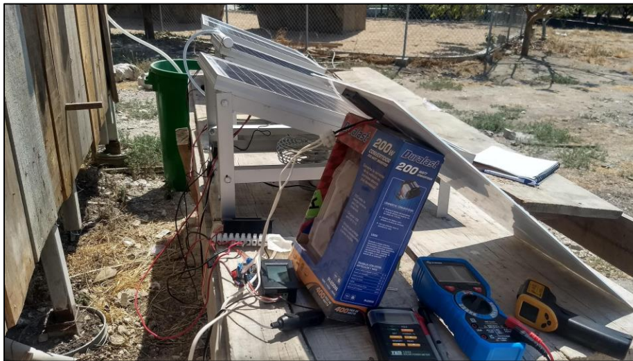
Figura 4.4 Parte posterior de los diferentes módulos fotovoltaicos evaluados.
