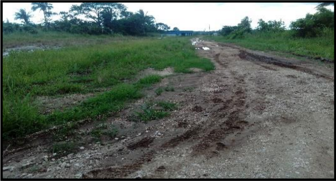
FIGURA 10 Calles en mal estado
