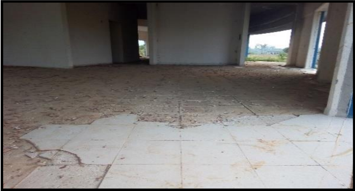
FIGURA 19 Piso de las instalaciones
