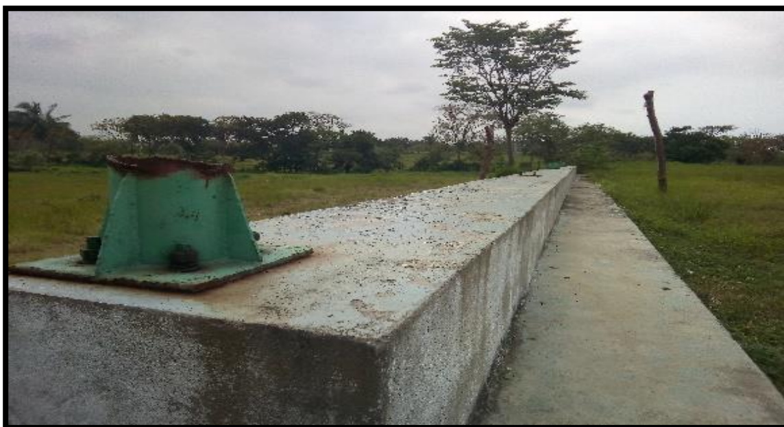
FIGURA 17 Restos de tubería
