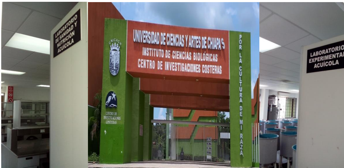
Figura 2. Instalaciones Centro de Investigaciones Costeras (CEICO).
