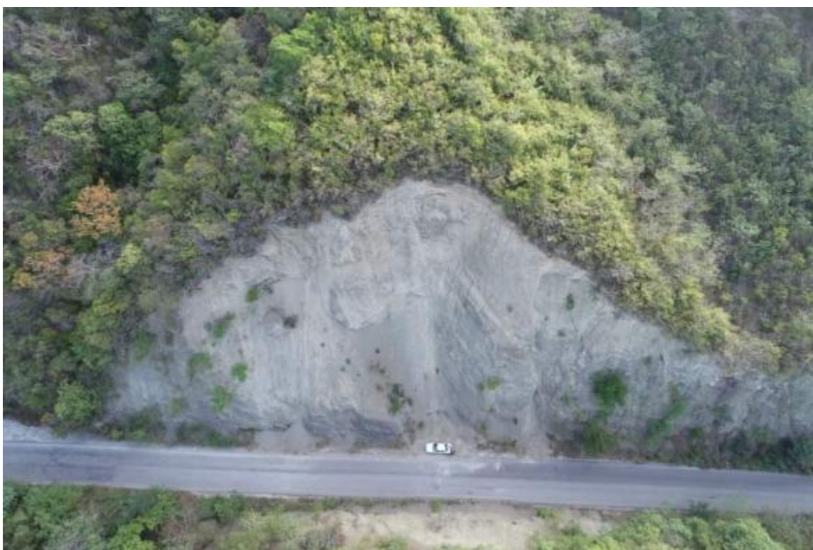
Figura No. 44.- Talud No 29; (Tomada con Phantom 4 Pro +, por Paz, noviembre 2019)
