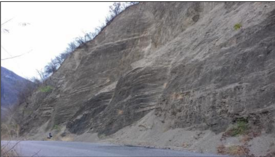
Figura No. 48. - Talud No 29, conglomerado-lutita-caliza; (Fuente: Propia)
