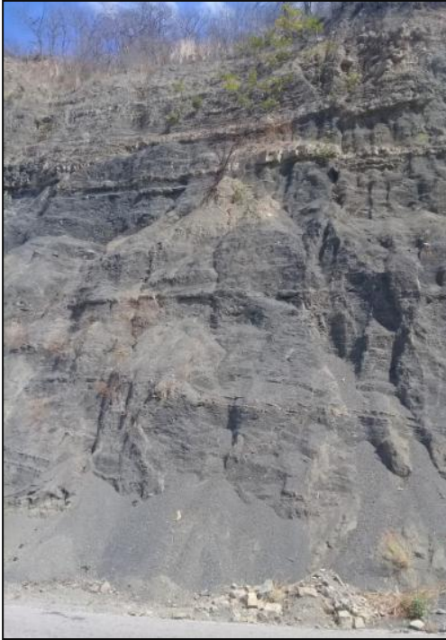
Figura No. 48. - Talud No 29, conglomerado-lutita-caliza; (Fuente: Propia)
