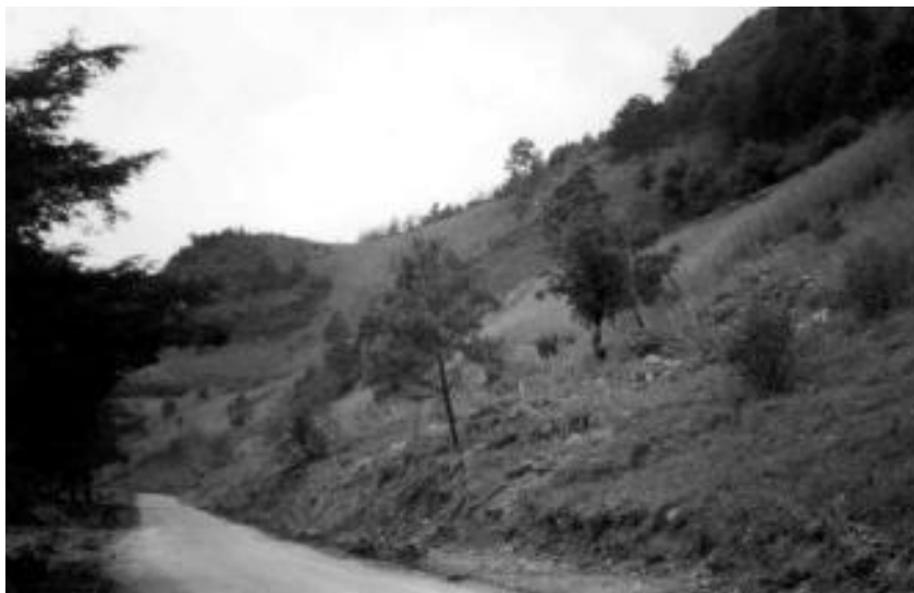
Figura No. 17. Deslizamiento traslacional; (CENAPRED, 2008)
