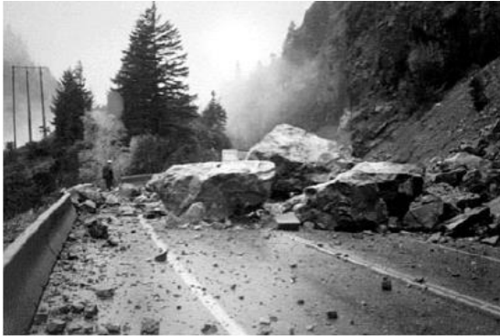
Figura No. 10. Los caídos o derrumbes ocurren con frecuencia en las carreteras; (CENAPRED, 2008)
