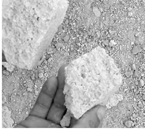
Figura 1. Fragmento de bloque de concreto contaminado con materia orgánica, la pieza corresponde a un fabricante de San Cristóbal de Las Casas, Chiapas.
