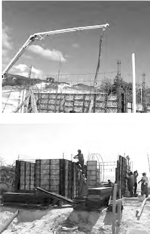
Figura 5a y b. Elaboración de viviendas de dos niveles de concreto celular en un fraccionamiento del norte oriente de Tuxtla Gutiérrez.
