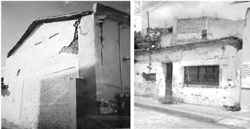
Figura 13. Estructura de adobe de la ciudad de Tuxtla Gutiérrez (fotografías cortesía de ingeniero José Alfredo Chan).
