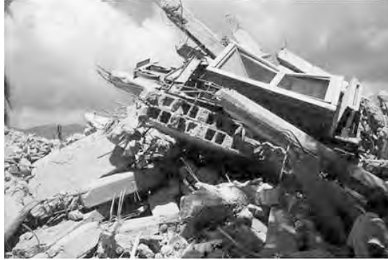
Figura 27b. Vistas generales del colapso del hotel Costa Real días después del sismo.
