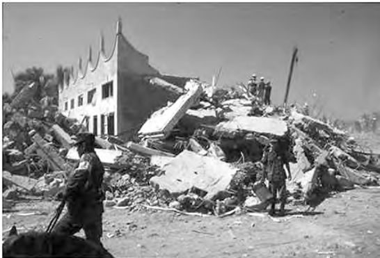
Figura 27a. Vistas generales del colapso del hotel Costa Real días después del sismo.
