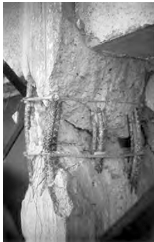
a) Columna corta, hotel Moronda Casa Grande.
