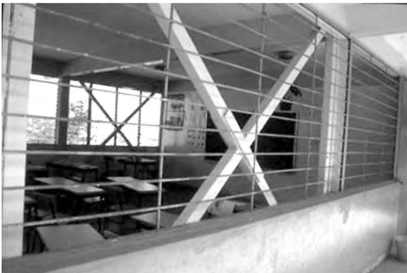
Figura 34. Escuela en Manzanillo reparada con contravientos metálicos con excelente comportamiento.
