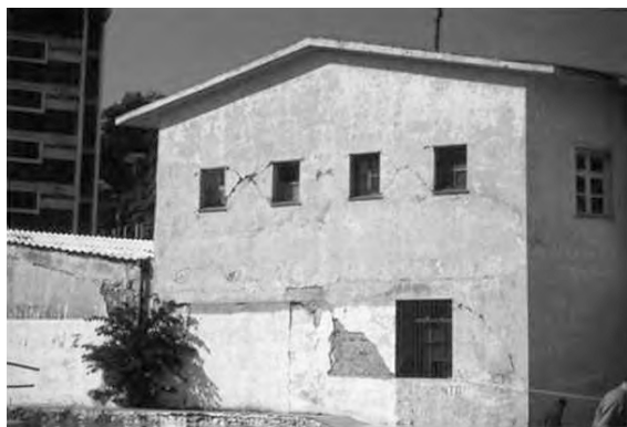
a) Edificio de correos.
