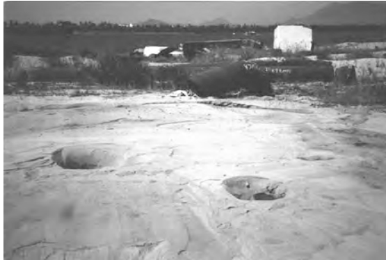
Figura 2. Licuación de arenas en la zona portuaria durante el sismo de Manzanillo (Web Berkeley, 2004).
