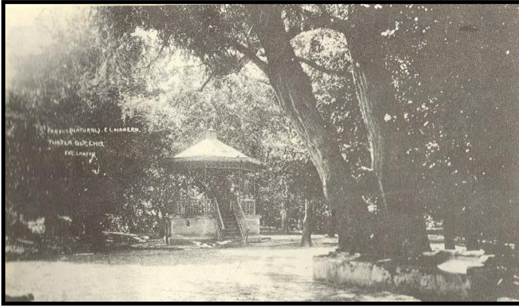
Fotografía de un apartado del Parque Francisco I. Madero. Archivo General del Estado de Chiapas (A.G.E.CH). Área sala Tuxtla. Foto 5.
