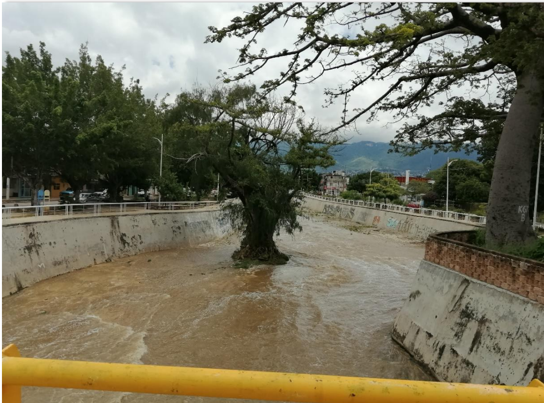
Andadores de la 4ª Norte entre 5ª y 6ª Oriente. Foto 169.
