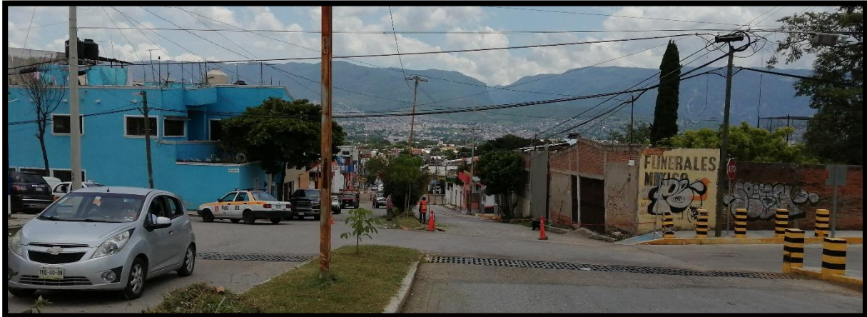
El Cerro de la Jolota fue partido a la mitad para construir la carretera que conecta con la calle de La Pensil saliendo al Libramiento Sur, en esta fotografía se muestra el inicio de la carretera, al fondo se puede apreciar las montañas del Cañón del Sumidero. Foto 102.
