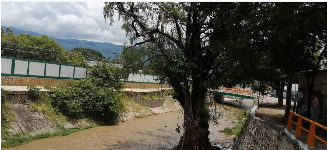
Panorámica tomada desde otro ángulo de Puente de la 5 Av. Norte entre 1ª Oriente y Calle Central, aquí se puede apreciar uno de los contados Arboles de sabino que no fue talado durante el embobamiento del Rio Sabinal. Foto 177.
