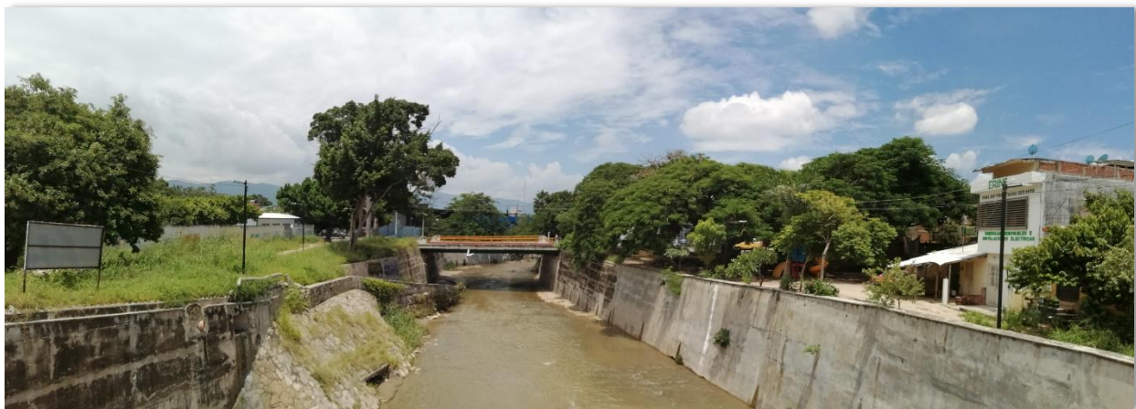
Puente y andadores de la 12ª Poniente entre 4ª y 5 Av. Norte, fotografía tomada hacia el oriente. Foto 202.
