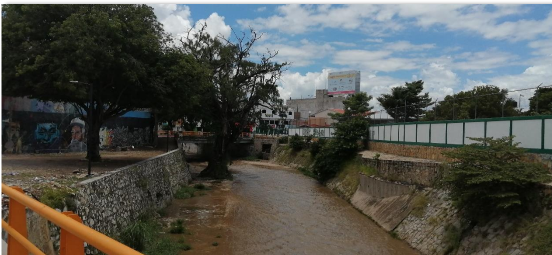
Puente 21 de Octubre de la 1ª Oriente. Foto 175.
