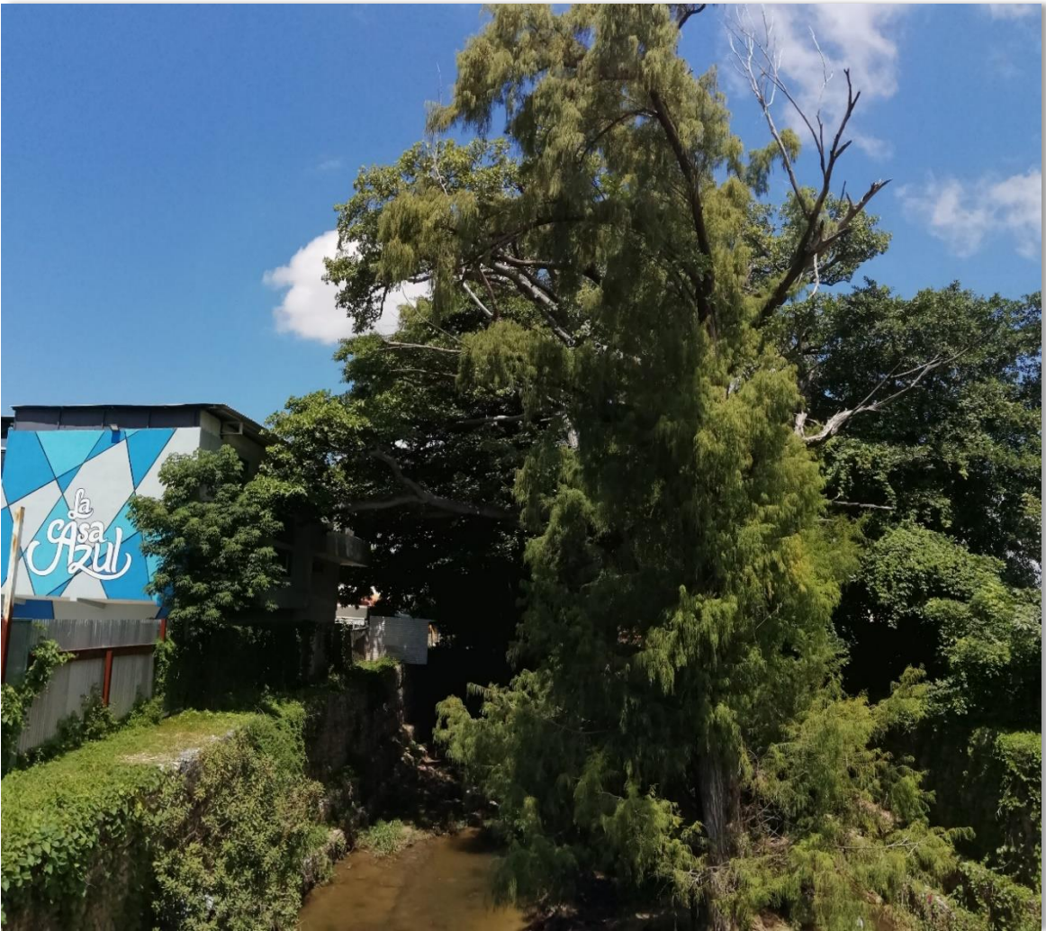
Fotografía del andador del puente de la 3ª Norte y Calza de Terán. Foto 337.
