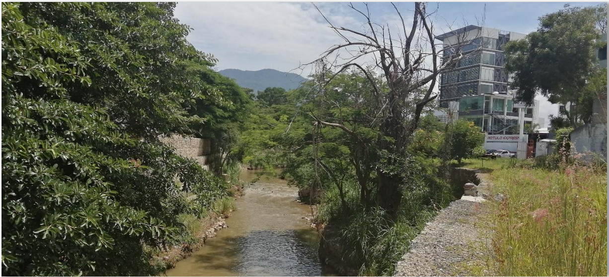
Puente y andadores de la 16ª Poniente, fotografía tomada viendo hacia el poniente.
