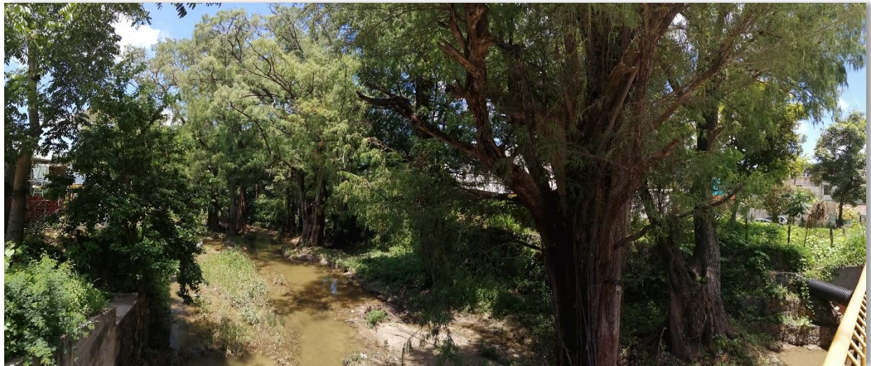
Puente de la 3ª Poniente y 3ª Sur. Foto 342.
