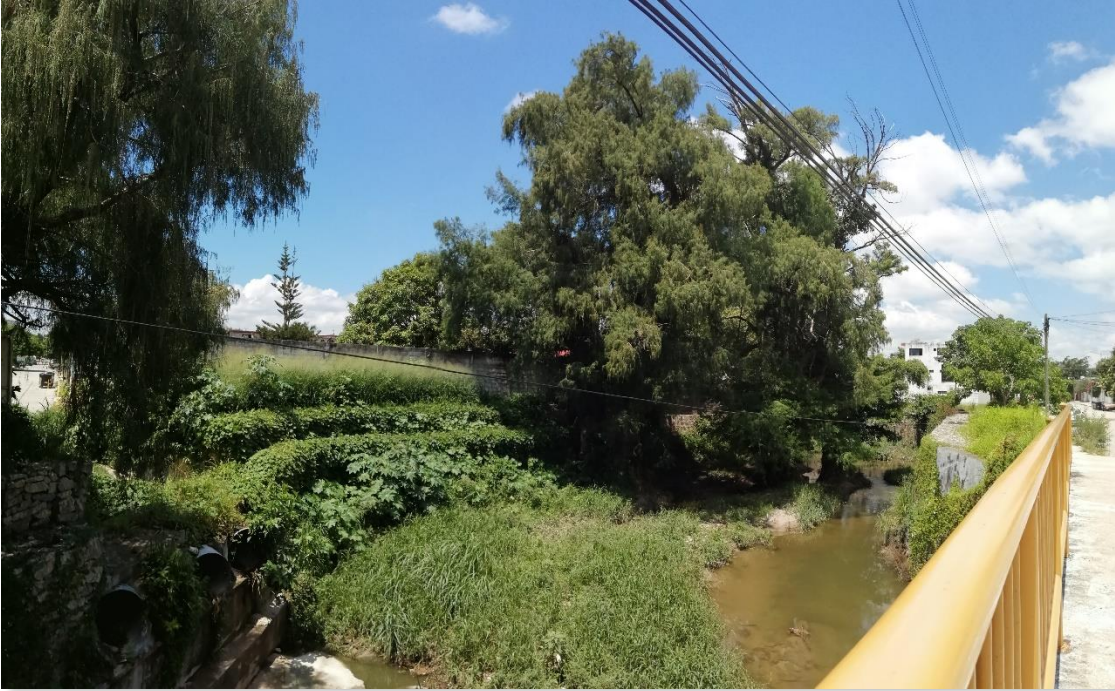
Puente de la 2ª Norte y Calzada de Terán.
