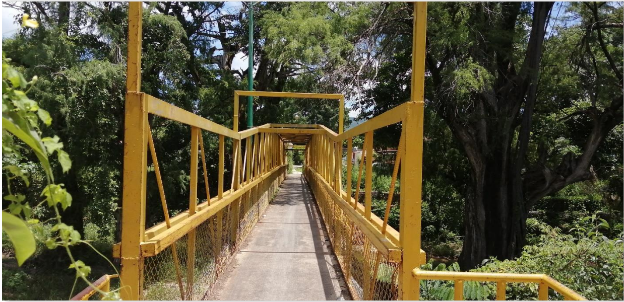
Tercer puente intermedio de la 4ª Poniente y 4ª Sur Terán cerca de la Unidad Habitacional Militar Tuxtla II y La Base Aérea Militar. Foto 350.
