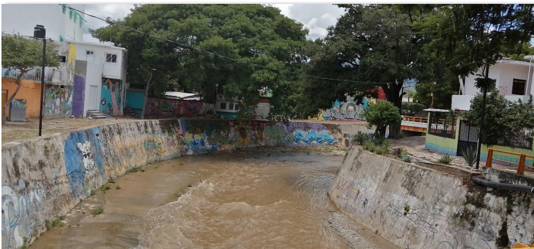
Puente de la 5 Av. Norte entre 1ª oriente y Calle Central. Foto 176.
