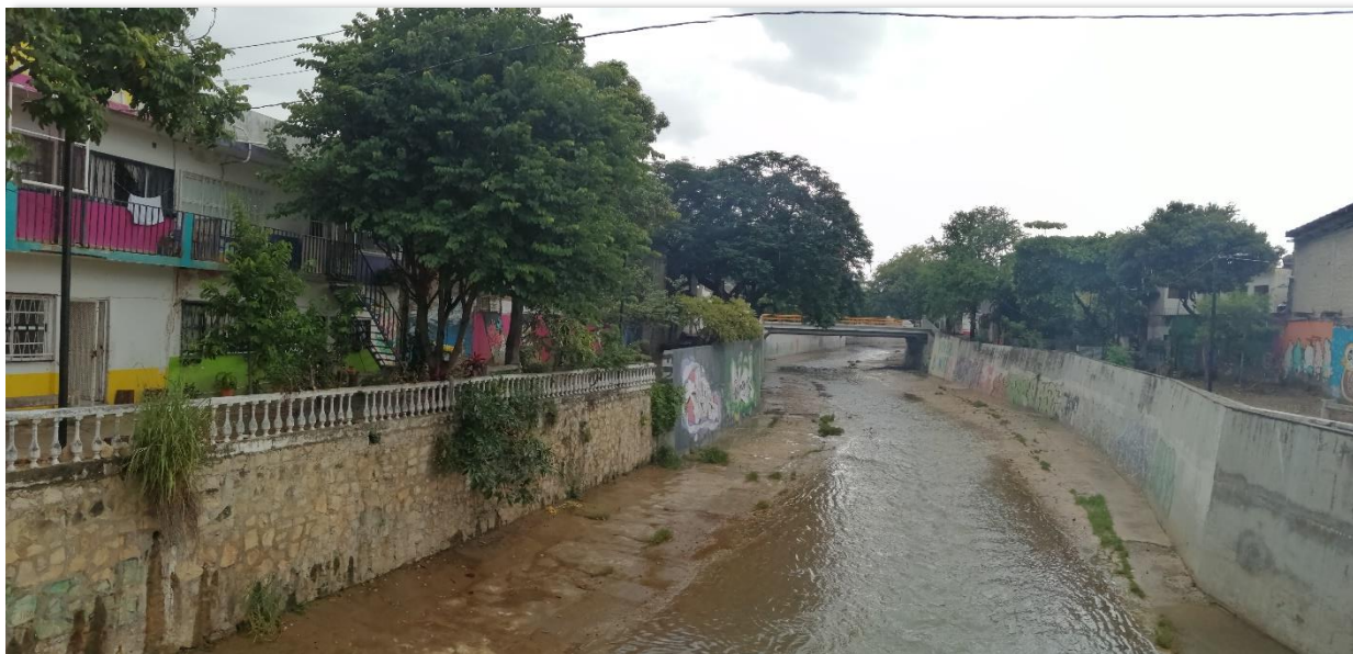
Puente y andadores de la 1ª Poniente entre 4ª y 5 Av. Norte, foto tomada viendo hacia el lado oriente. Foto 180.
