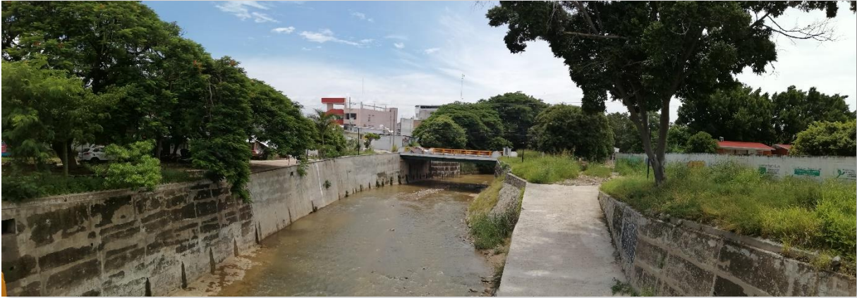
Puente y andadores de la 11ª Poniente entre 4ª y 5 Av. Norte, aquí se puede ver la rampa que da acceso a la maquinaria pesada que limpia al Río Sabinal, al fondo de lado derecho se puede observar los techos de La Escuela Primaria Margarita Maza de Juárez o Escuela David Gómez. Fotografía tomada hacia el lado poniente. Foto 200.
