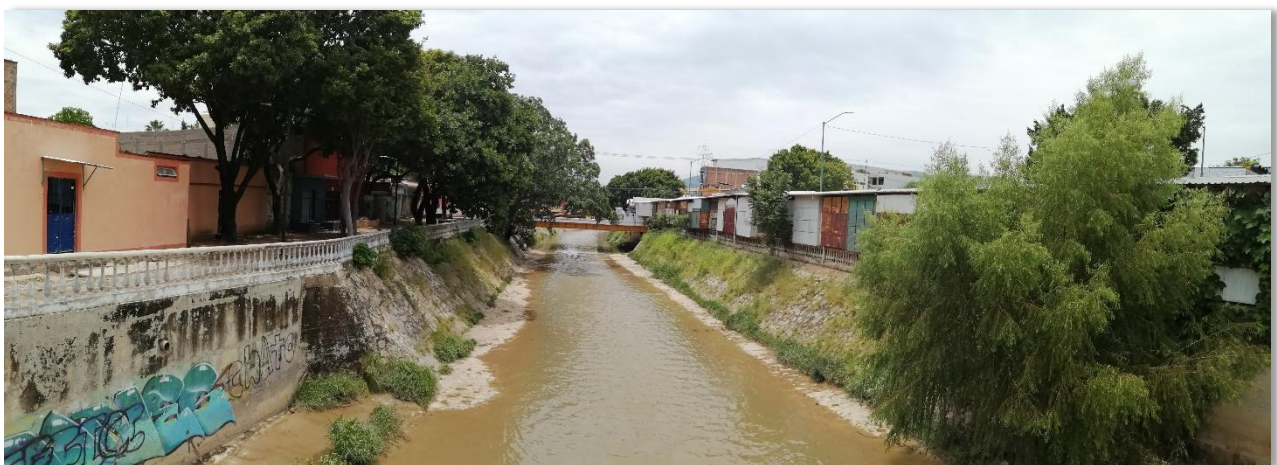
Mismo puente y andadores de la 4ª Poniente entre 4ª y 5 Av. Norte, de lado derecha de puede apreciar un joven árbol de sabino y el tianguis conocido como "La Fayuca". Foto capturada viendo hacia el lado poniente. Foto 187.
