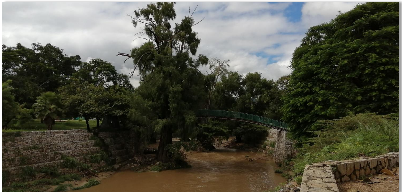
Andador y segundo puente aunado al parque del oriente a un costado del Libramiento Norte, desde que se inicia el recorrido se han observado árboles de sabino.
