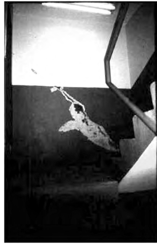
Figura 15. Daño típico en estructuras con base en marcos donde no se desligan adecuadamente los muros ni se considera su interacción. Central de TELMEX.
