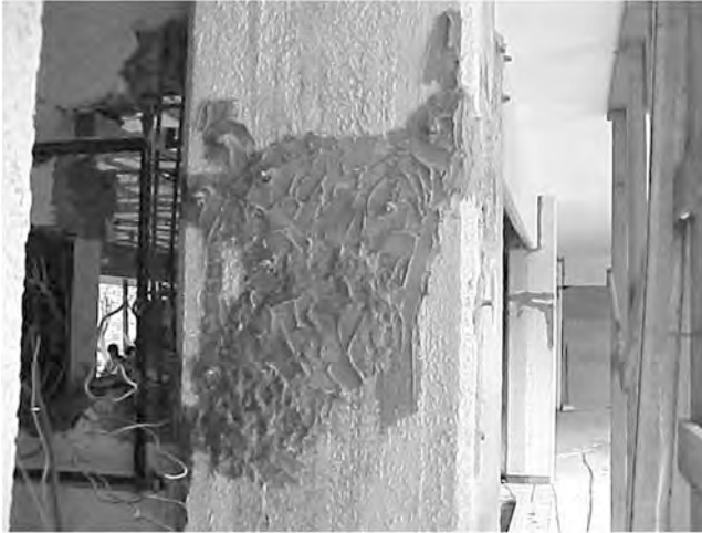
Figura 6. Inyección de grietas.
