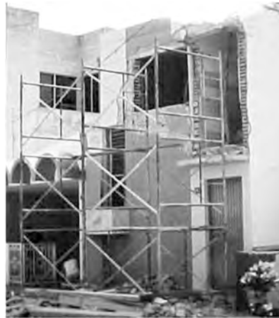
Figura 10. Daños en muros de mampostería sin refuerzo en el estado de Colima (fotografía cortesía de Raúl Vera Noguez).
