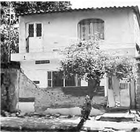
Figura 10. Daños en muros de mampostería sin refuerzo en el estado de Colima (fotografía cortesía de Raúl Vera Noguez).
