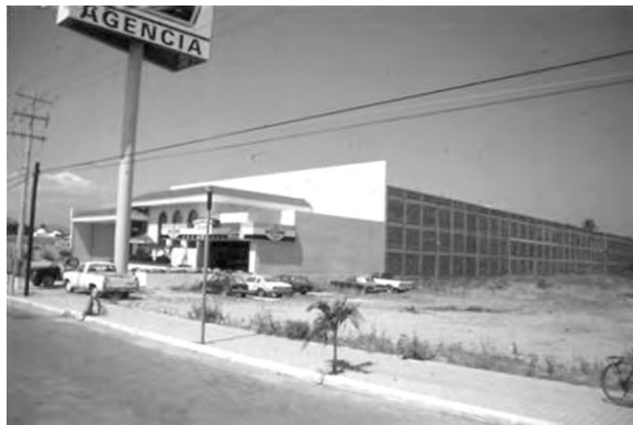
Figura 8a. Comportamiento excelente de la bodega de la Cervecería Modelo, estructurada con base en mampostería confinada conforme a las NTCM.
