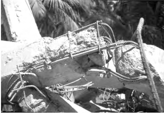
Figura 28b. Evidencia del armado original de las columnas del hotel Costa Real.
