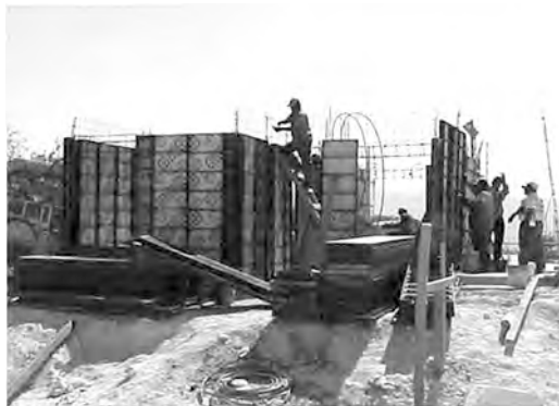
Figura 5a y b. Elaboración de viviendas de dos niveles de concreto celular en un fraccionamiento del norte oriente de Tuxtla Gutiérrez.
