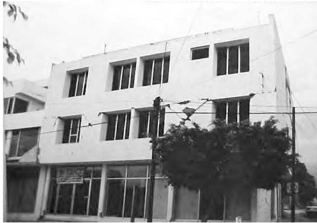
Figura 17a. Estructura de mampostería confinada en la ciudad de Tuxtla Gutiérrez (fotografías cortesía de maestro Raúl Vera Noguez).
