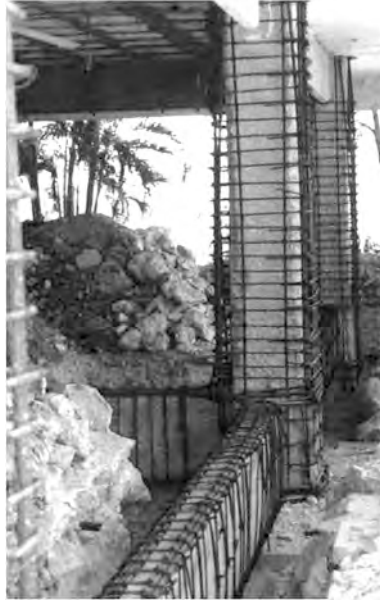
Figura 7. Refuerzo en columnas y contratraves mediante encamisado.
