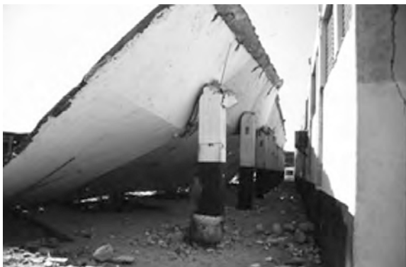
Figura 5b. Colapso del paraguas de la terminal de autobuses de Manzanillo.
