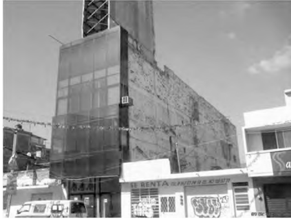
Figura 22b. Edificio en el centro de Tuxtla Gutiérrez, Chiapas
