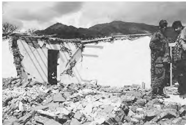
Figura 3a. Daño en estructuras de adobe en la población de Nuevo México, municipio de Villaflores (fotografías cortesía del ingeniero José Alfredo Chan).
