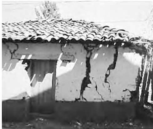
Figura 2a. Daños en estructuras de adobe donde la poca resistencia del material y el efecto del diafragma flexible causa daños muy importantes (fotografías cortesía de Raúl Vera Noguez).
