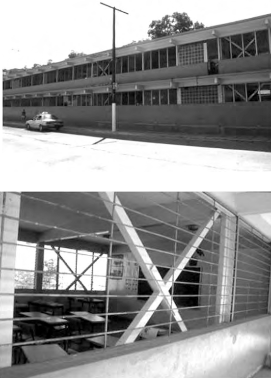
Figura 34. Escuela en Manzanillo reparada con contravientos metálicos con excelente comportamiento.
