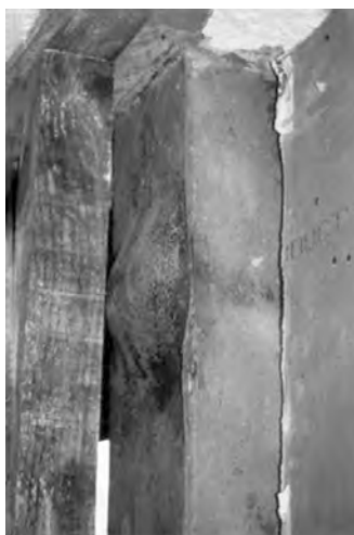
Figura 31. Vistas generales del daño presentado en el hotel Vidafel por su gran flexibilidad lateral (fotos cortesía de Óscar de la Torre Rangel).
