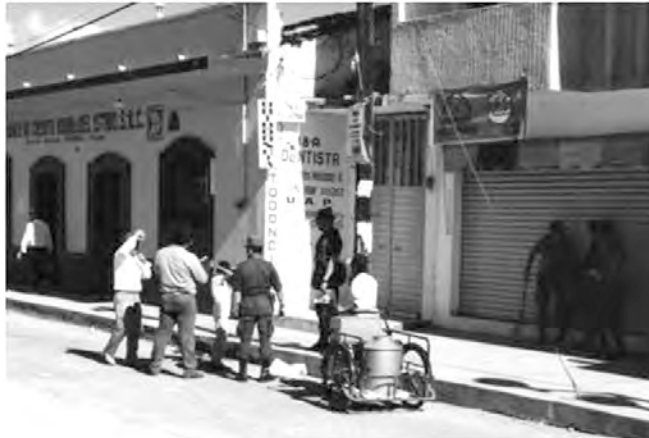
Figura 5. Daños en la cabecera municipal de Villaflores (fotografías cortesía del ingeniero José Alfredo Chan).
