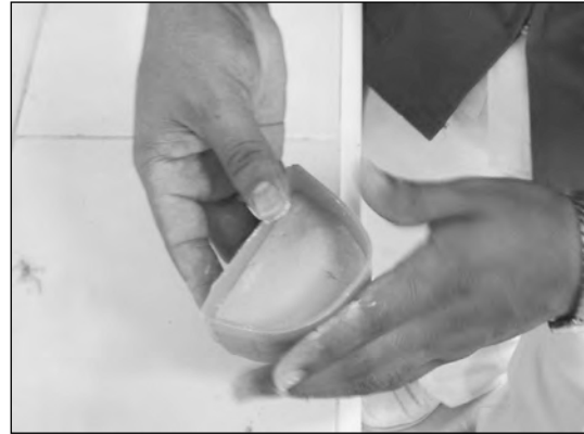
Vaciado del yeso en el zócalo (figura 17).
