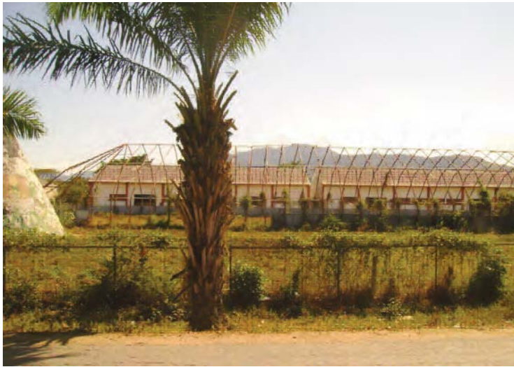
Instalaciones abandonadas de la antigua CONASUPO.
