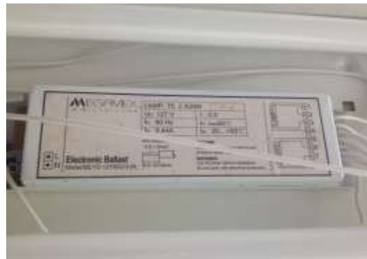
Imagen 4.2.3B Balastro para lámparas fluorescente del taller.
