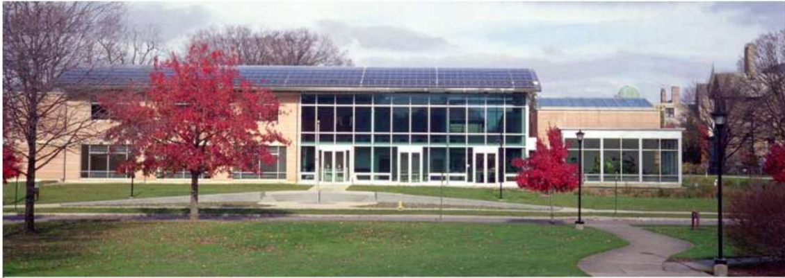
Imagen 1.1 Sistema fotovoltaico del edificio Adam Joseph Lewis Center for Environmental Studies en Oberlin, Ohio. USA. [8].
