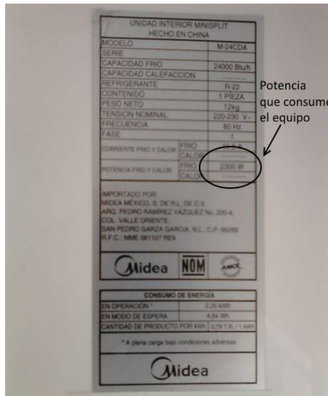
Imagen 4.2.4 Datos de placa de sistemas de Aire Acondicionado Cada aire acondicionado cuenta con una placa en donde el fabricante especifica datos importantes como Voltaje de operación, máxima corriente demandada y potencia nominal del equipo.
