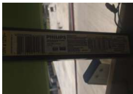
Imagen 4.2.1B Balastro Philips 2x32
