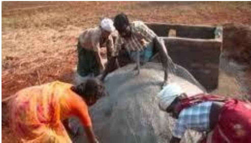
Fig. 2.8 Instalación de un biodigestor en Nepal.
