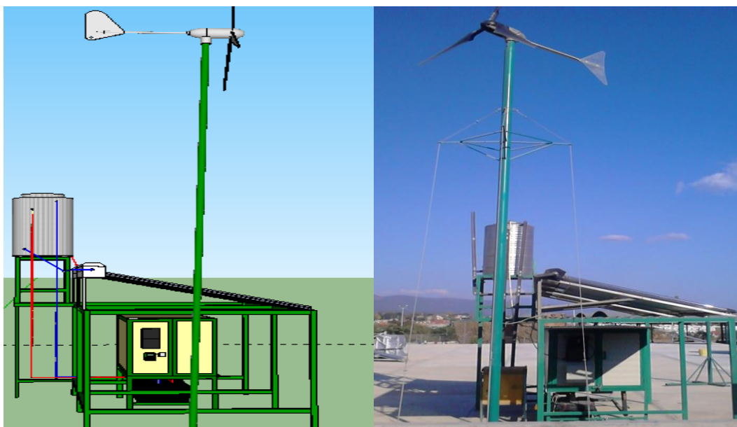
Figura 3.4. Estructura general del sistema híbrido termosolar-eólico.
