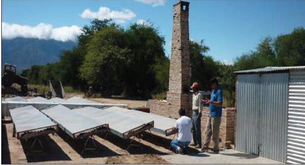
Figura 1.4. Secador. Vista lateral este – oeste, con colectores dirigidos al norte.
