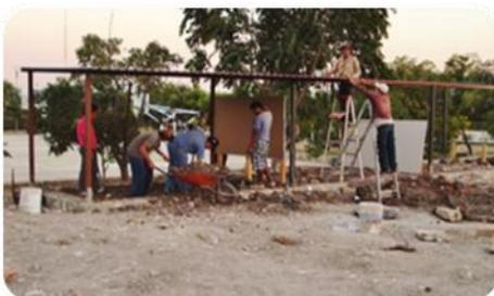
**Figura 15. Instalación de paredes de tabla roca.**
