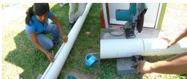
Figura D.2: Corte de tubo a 1 m y 50 cm.
