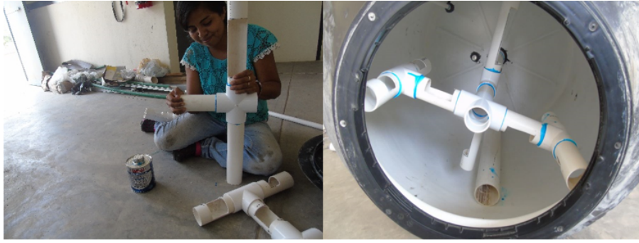
Figura B.4: Construcción del sistema de agitación.
