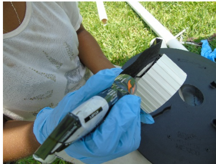
(b) Colocación de empaque y silicón en conector de rosca exterior
