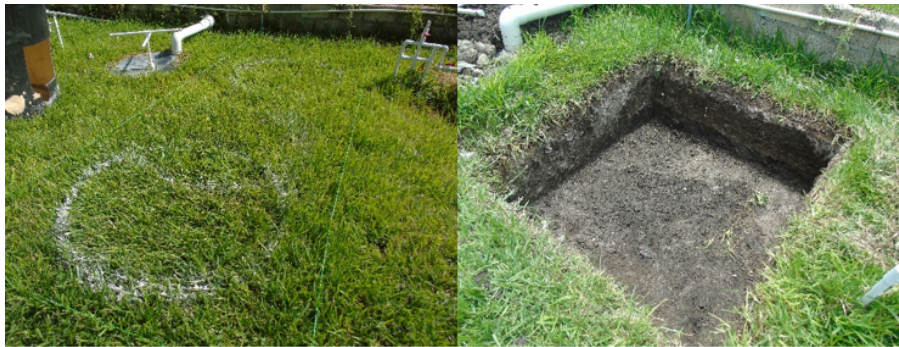
Figura B.5: Realización del hueco que contendrá el biodigestor.
