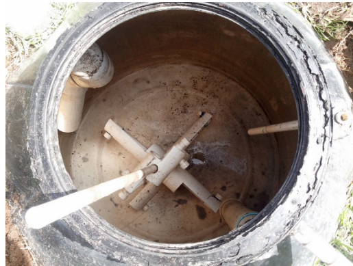
(b) Realizando limpieza
