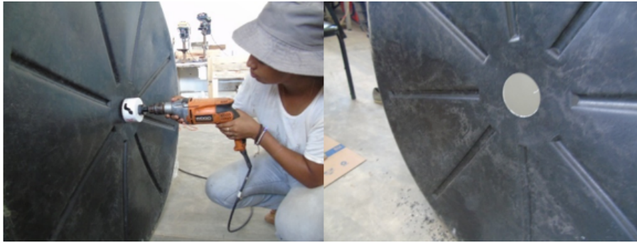
Figura B.2: Realización de orificios.
