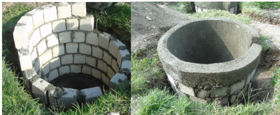
Figura B.6: Construcción de base para el biodigestor.
