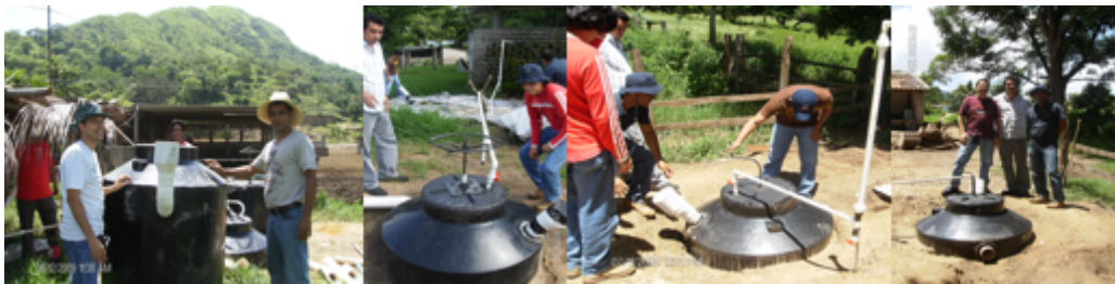
Figura 1.3: Biodigestores rígidos modelo DM1 instalados en diferentes comunidades del estado de Chiapas.
