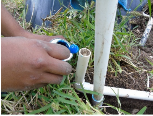
(a) Colocando pegamento
