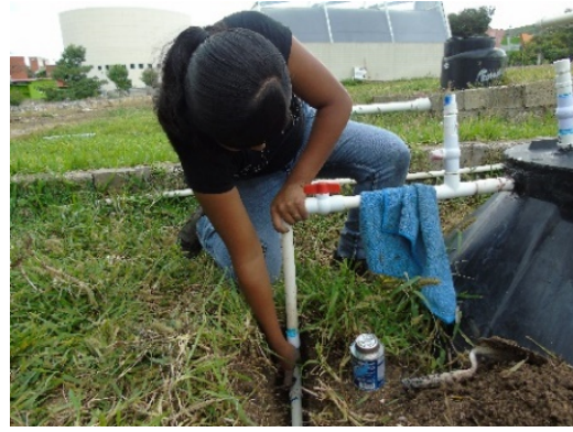
(b) Uniendo la tubería
