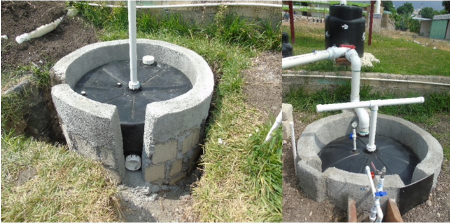
Figura B.7: Instalación del sistema de biodigestión.
