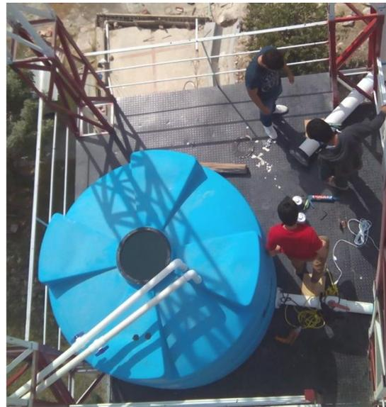
*Fig.4.12 Barandales de seguridad en plataformas (Medina, Fotografía, 2014).*
