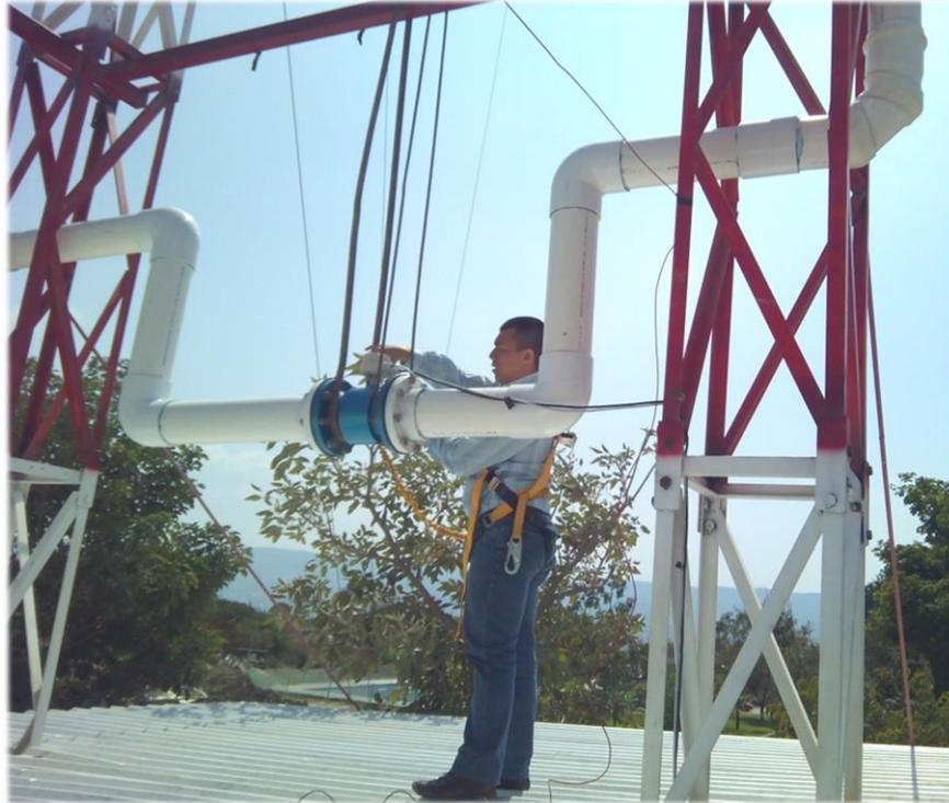
Fig. 4.23 Instalación de Caudalimetro (Medina, Fotografía, 2014).
