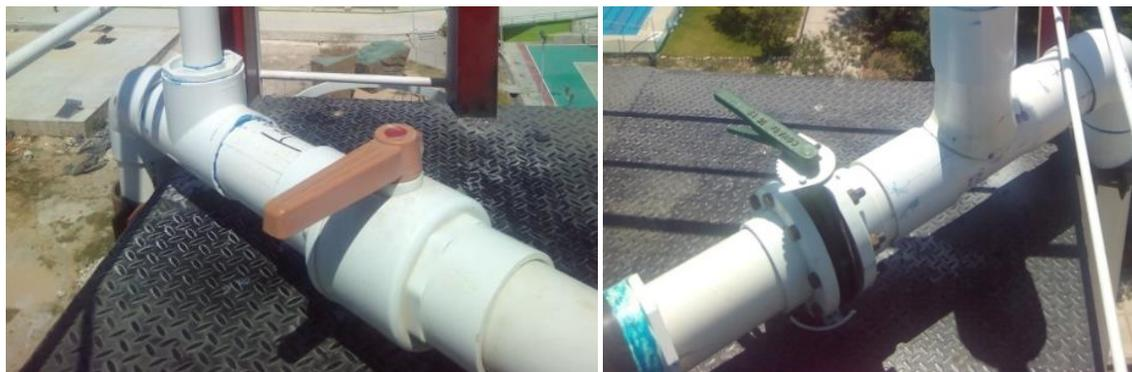
Fig. 5.3.- Válvula tipo esfera para 4 in y Válvula tipo Wafer para 6 in (Medina, 2014).
