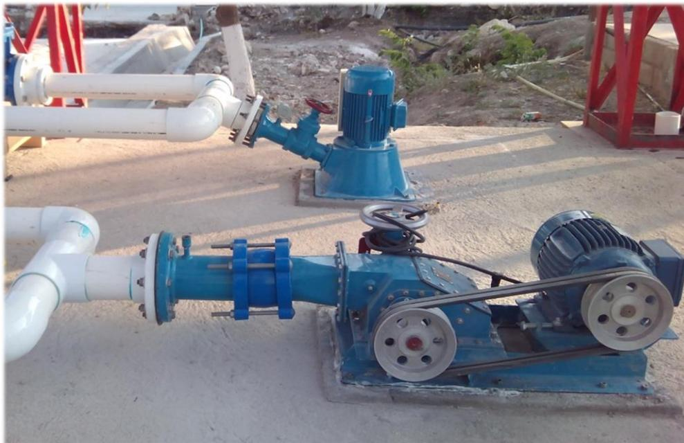
Fig.4.30. Sistemas micro hidroeléctricos instalados (Medina, Fotografía, 2014).
