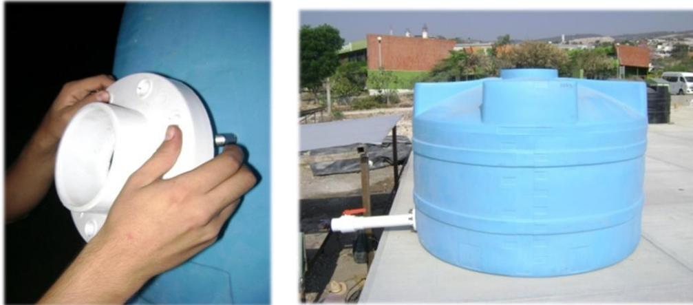
*Fig. 4.20. Adecuación de Bridas de 4 y 6 in en Cisternas (Medina, Fotografía, 2014).*
