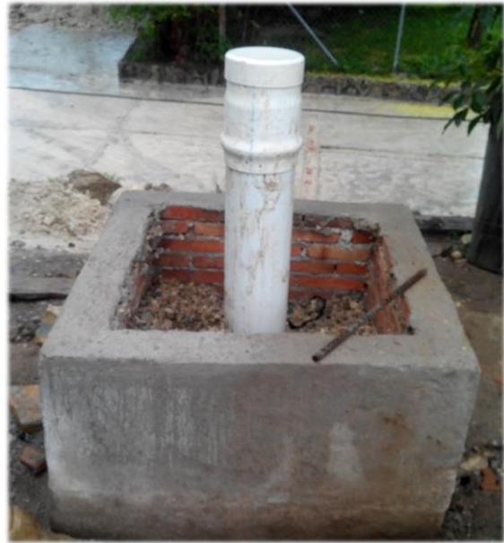
*Fig.4.19. Tubería instalada en el Pozo (Medina, Fotografía, 2014).*
