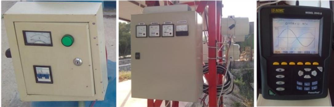
Fig. 5.8.- Tablero de control y medidor de Calidad de Energía. (Medina, 2014).
