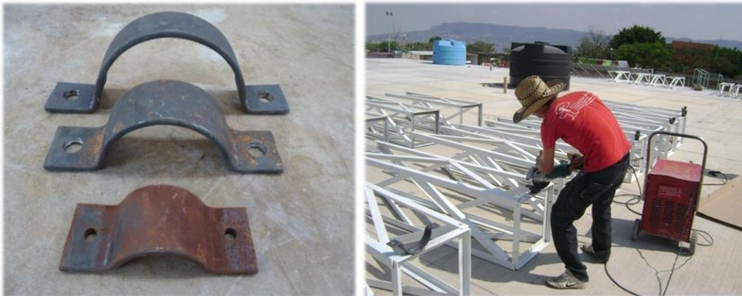
*Fig.4.7. Adaptación de abrazaderas e instalación. (Medina, Fotografía, 2014)*
