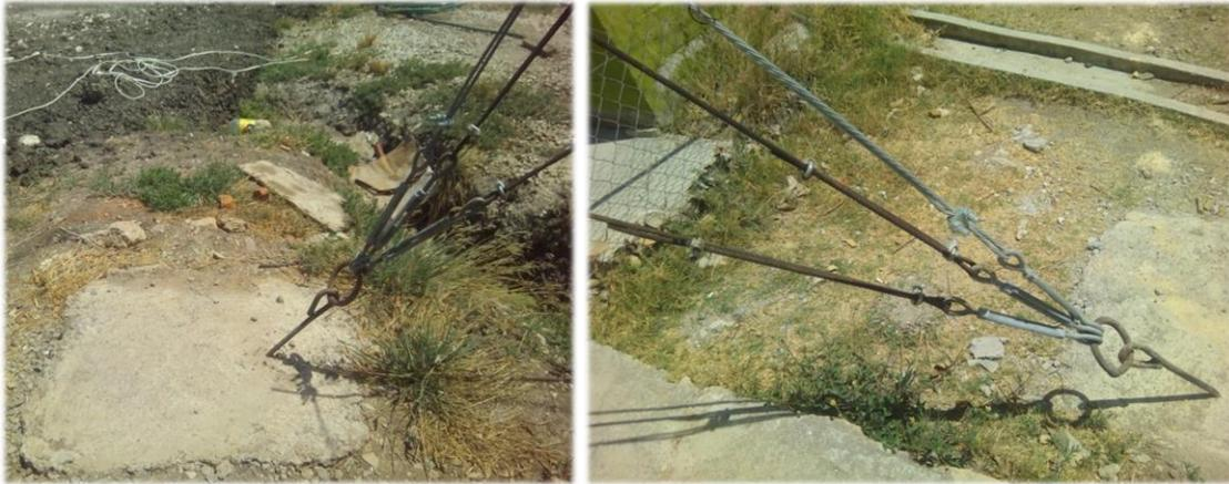
Fig. 4.9. Zapatas para tensores (Medina, Fotografía, 2014).
