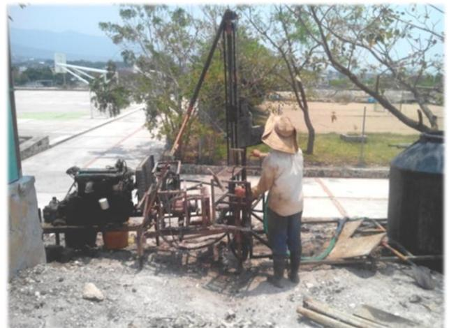
*Fig. 4.16 Instalación de Maquinaria para excavación* (Medina, Fotografía, 2014).
