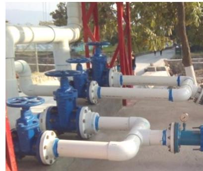
*Fig. 5.1.- Válvulas compuertas (Medina, 2014).*
