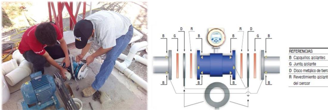
Fig. 4.36. Instalación de anillos de tierra, juntas aislantes y bridas en el medidor de flujo magnético (Medina, Fotografía, 2014)& (FUTEK).
