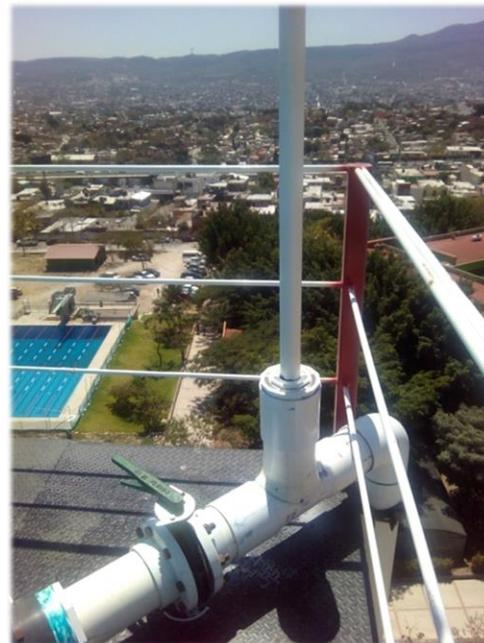
Fig. 4.26. Chimenea de Equilibrio de PVC Hidráulico (Medina, Fotografía, 2014).
