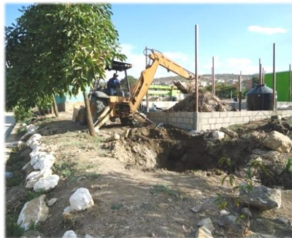
*Fig. 4.1.Excavación fosa de las Zapatas*
