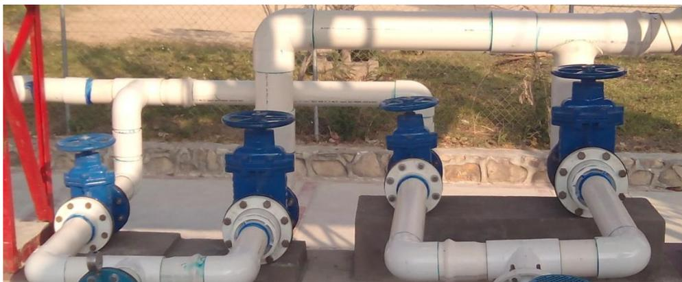
Fig. 4.24. Sistema de bifurcación y regulación de Caudal (Medina, Fotografía, 2014).
