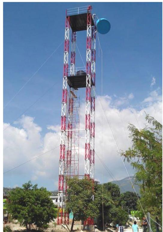
*Fig. 4.21. Instalación de Cisternas en las Plataformas (Medina, Fotografía, 2014).*
