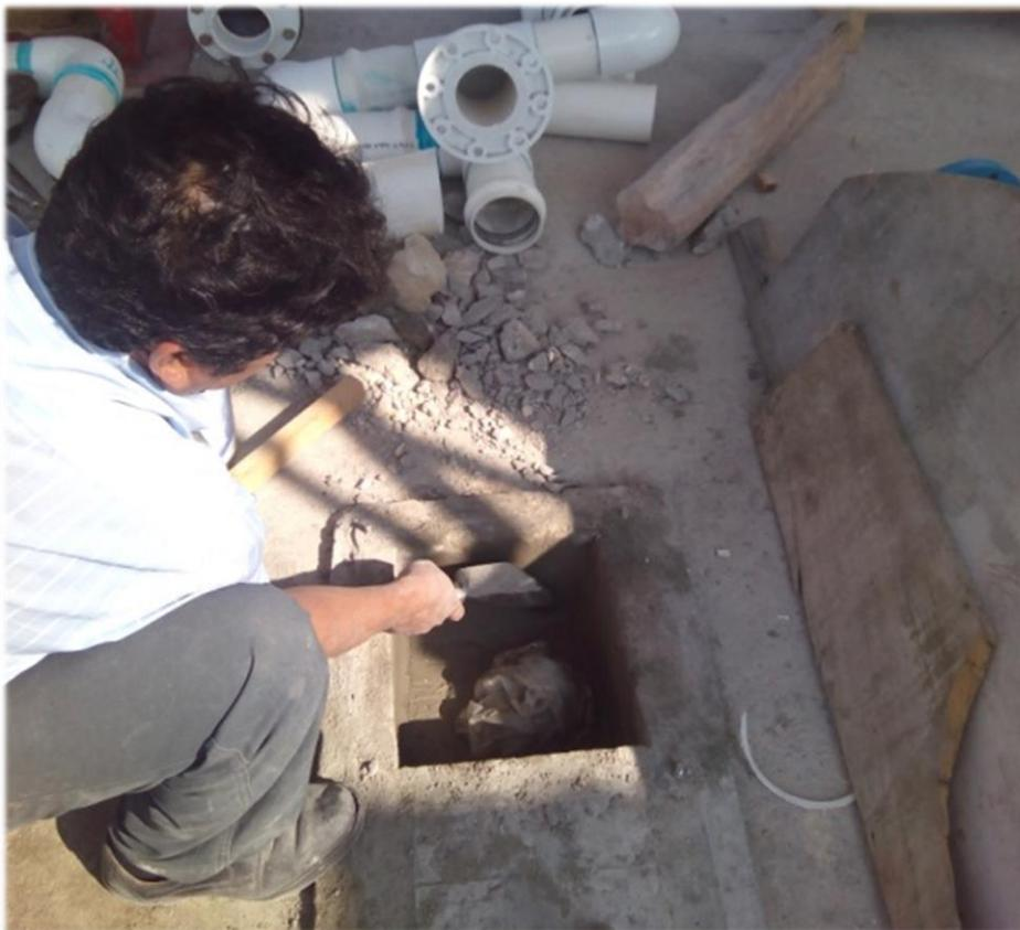
*Fig. 4.28 Bóveda de desfogue para el sistema micro hidroeléctrico
