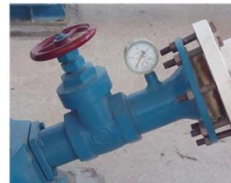
Fig. 5.7.- Válvula del inyector (Medina, 2014)
