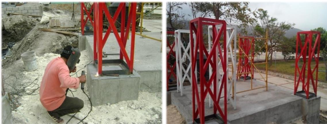
Fig. 4.6. Instalación de Armazones Metálicas (Medina, Fotografía, 2014).
