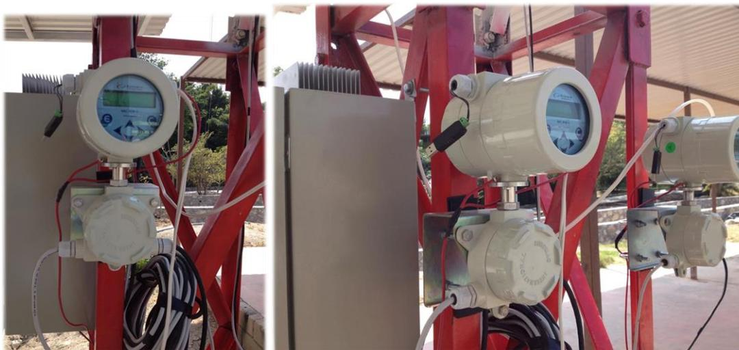
Fig. 4.37. Montaje de convertidor MC308c (Medina, Fotografía, 2014).
