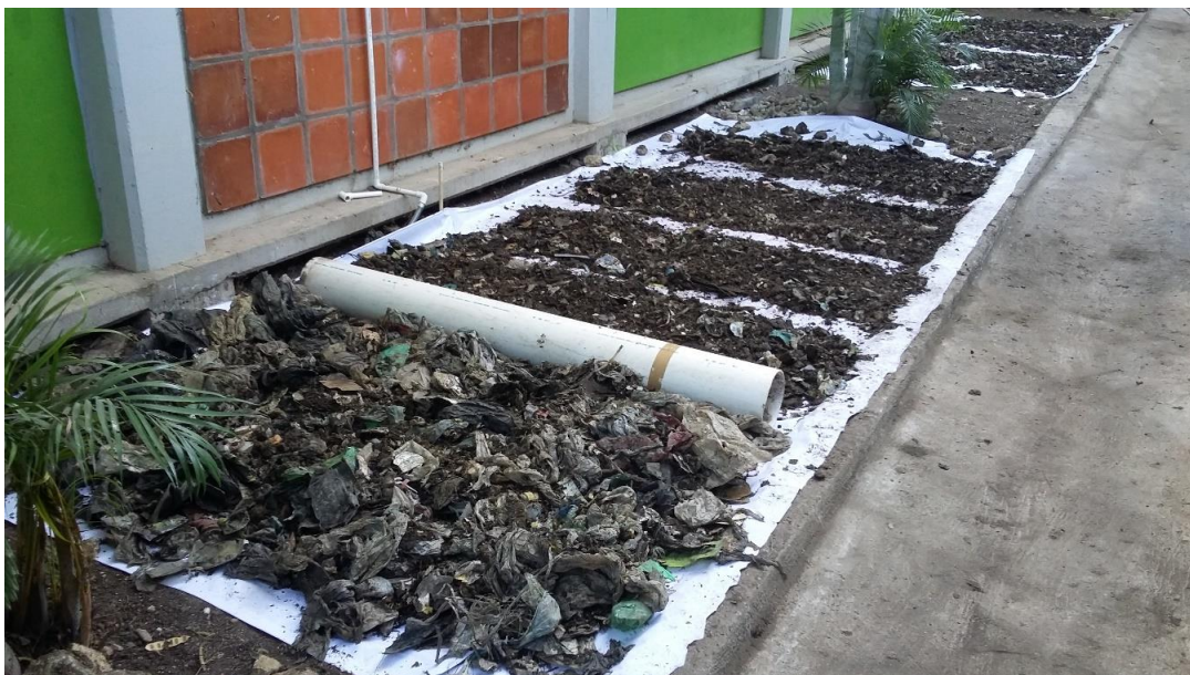
Figura 3. Colocación de los ME para su secado y caracterización de los materiales parcialmente secos (derecha) y materiales húmedos (izquierda).
