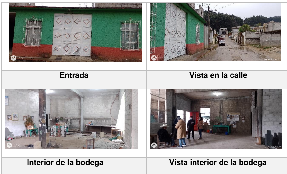
Figura 2. Toma de evidencias de las condiciones de la bodega.
