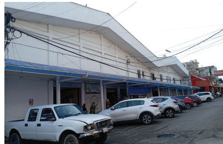
Fachada lateral del mercado
