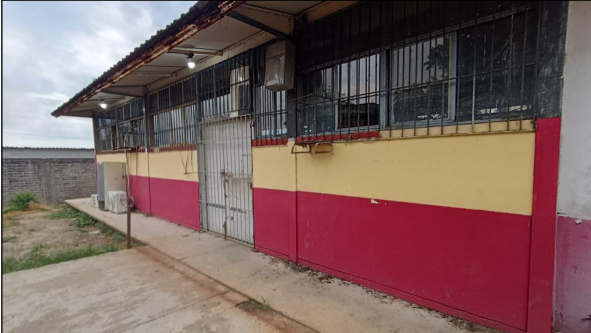
Figura 31 Salón de taller de climatización
