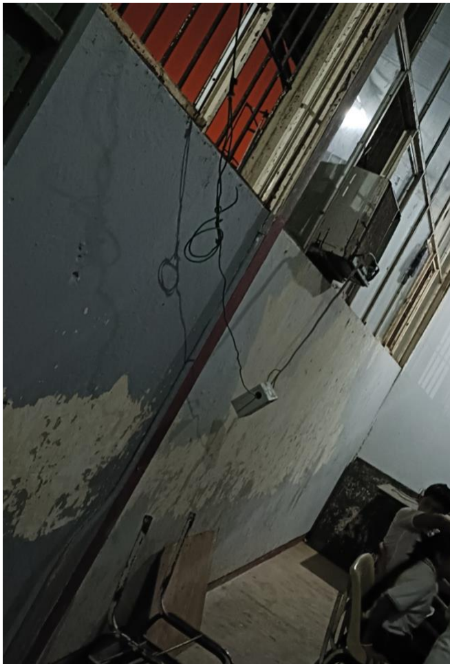
Figura 14 Cables expuestos
