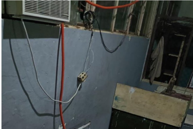
Figura 15 Cables expuestos
