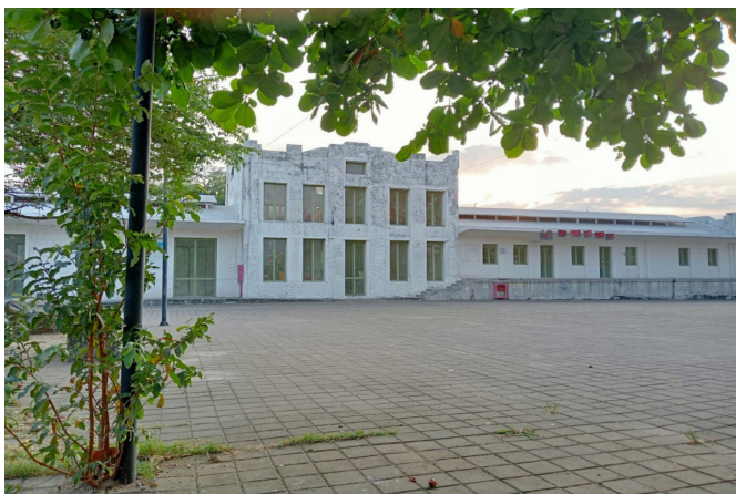
Fachada restaurada de la Estación ferroviaria. Foto: Astrid Maribel Pinto Durán, febrero de 2025.
