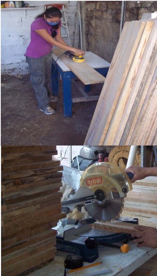
Fig. 4.18. Lijado y corte de tablas para construir aislante exterior.
