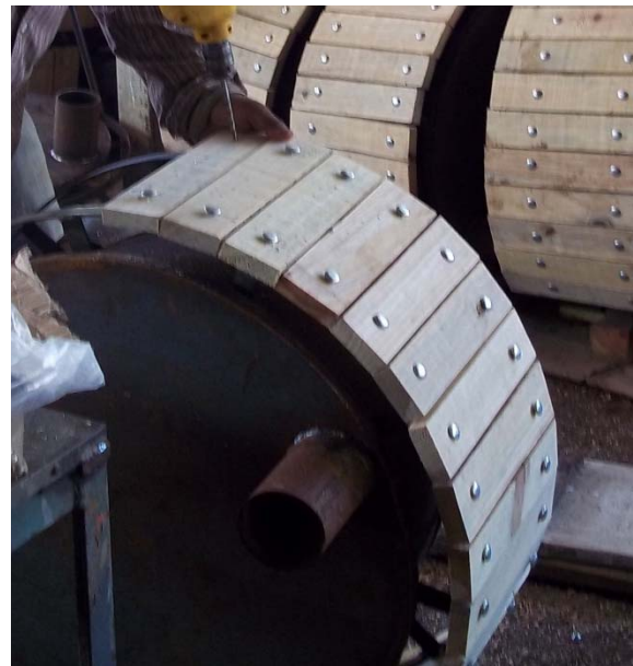
Fig. 4.20. Perforación de la cintilla y colocación de tablas para la función de aislante.
