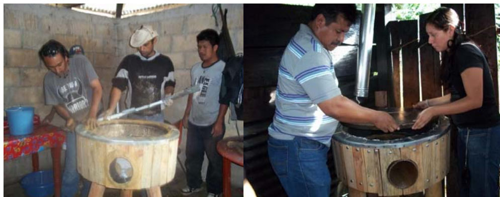
Fig.4.25 Colocación del comal. Fotos Pascual López
