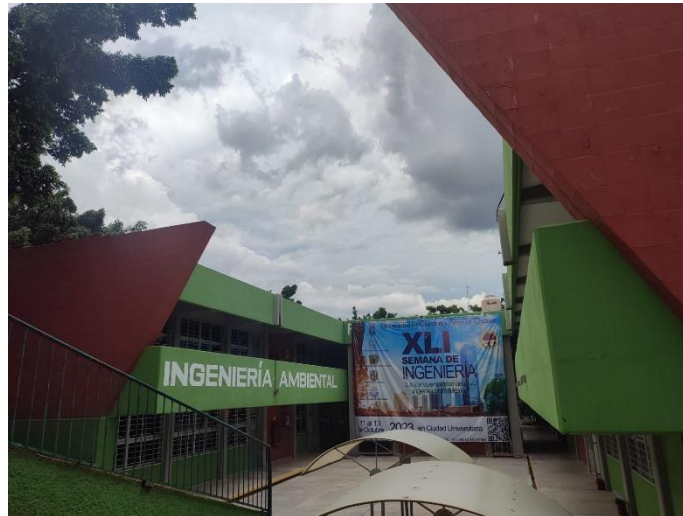
Imagen 3. Edificio de la Licenciatura en Ingeniería Ambiental.
