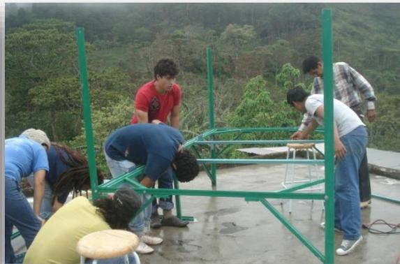
**Figura 4.7.** Estructura de soporte del secador solar desarmable.
