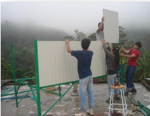
**Figura 4.8.** Paredes del secador solar.
