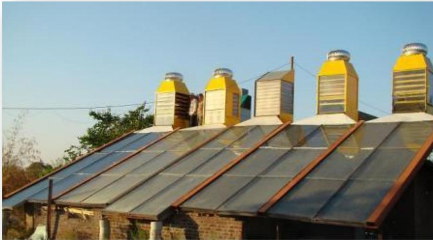
**Figura 3.8.** Secador solar mixto.
