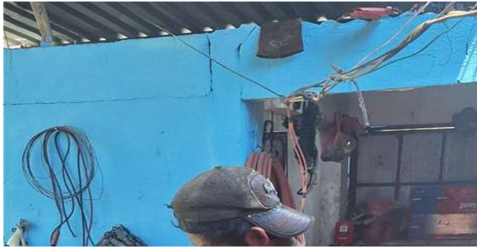
FIGURA 13. DEFICIENTES INSTALACIONES ELÉCTRICAS TALLER "EL BROTHER"
