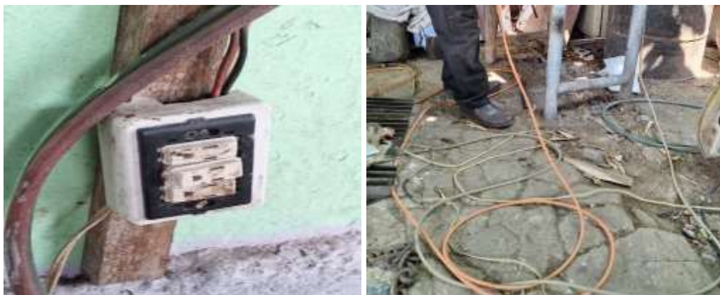
FIGURA 42. DEFICIENTES INSTALACIONES ELÉCTRICAS TALLER "EL ALMENDRO"
