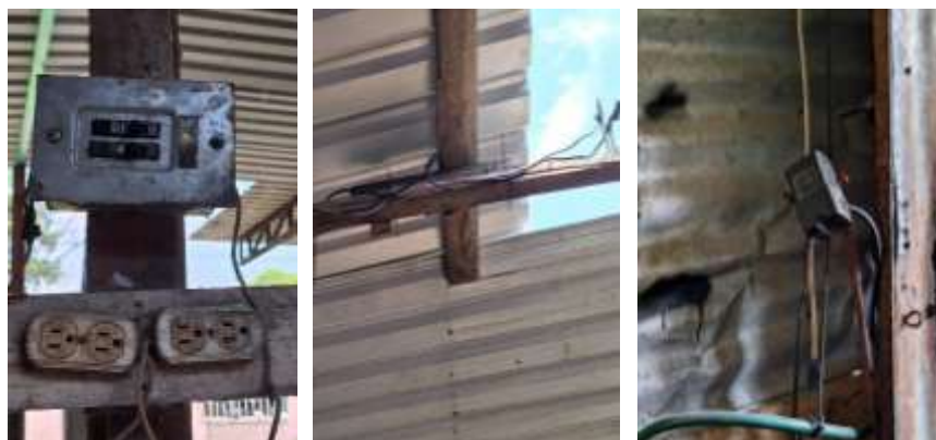
FIGURA 28.DEFICIENTES INSTALACIONES ELÉCTRICAS TALLER "EL BLANCO"
