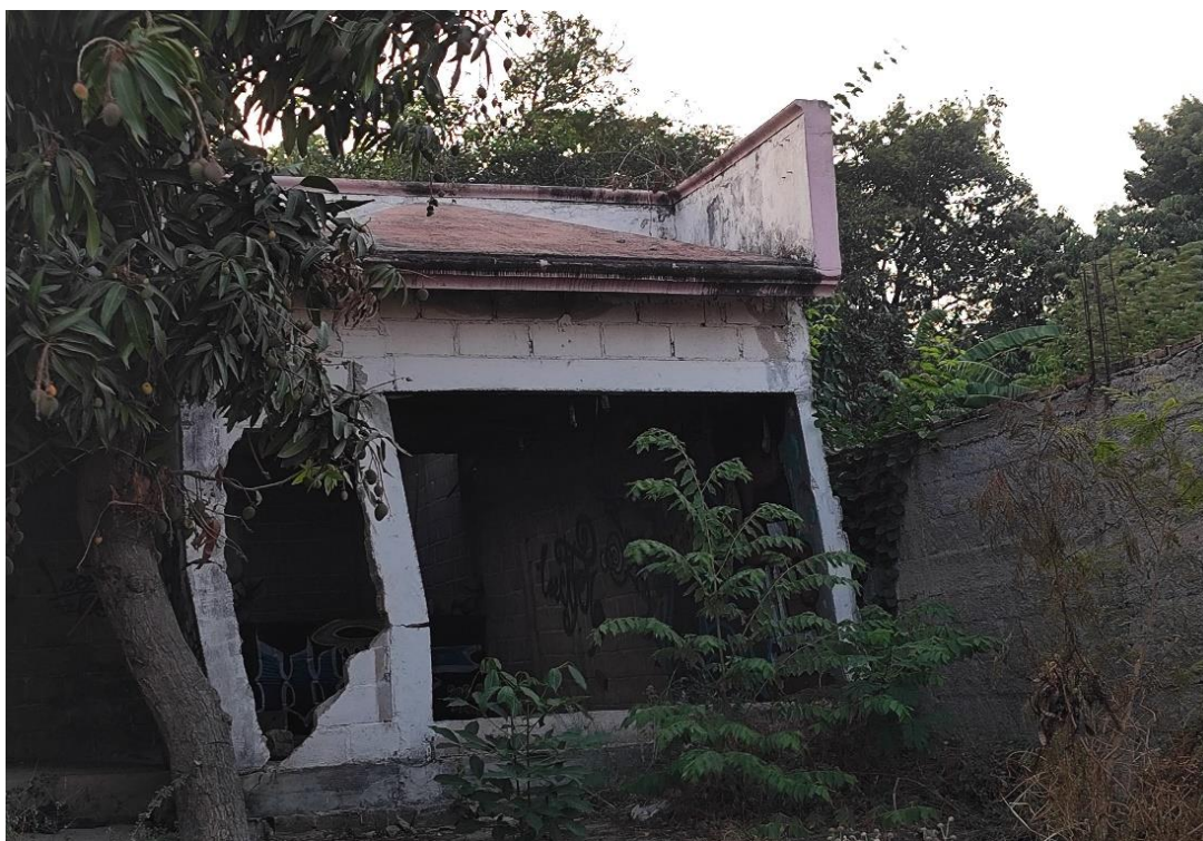
figura 28: vivienda con fallas ante el pandeo, en elementos estructurales verticales y así mismo podemos observar cómo el desplazamiento lateral relativo está fuera de lo permisible.
