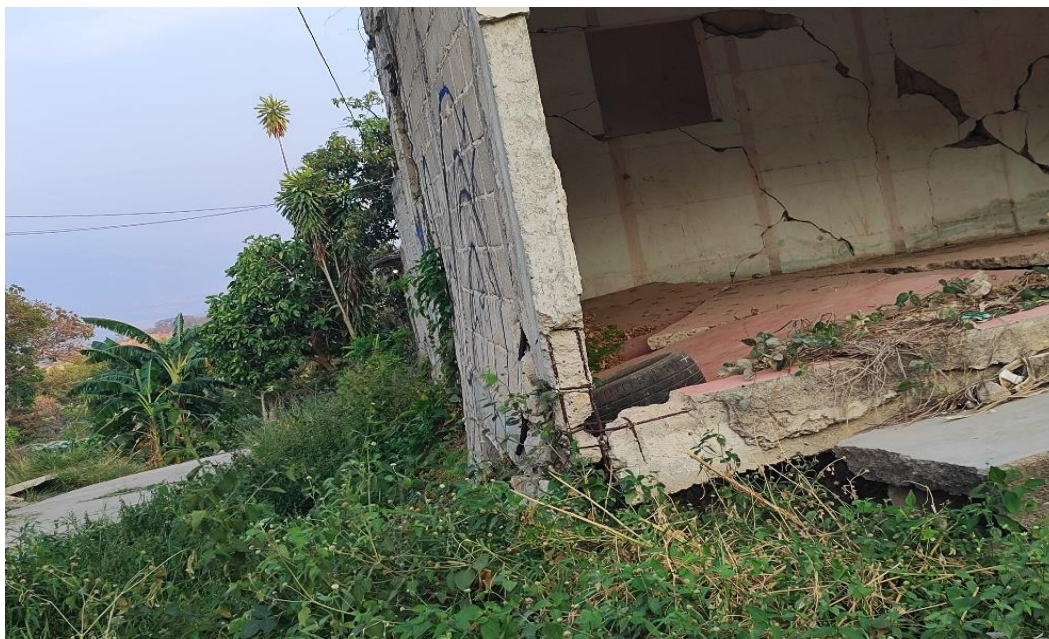
Figura 26: vista cercana de los elementos estructurales verticales con grietas, presentes al fondo y de los elementos de confinamiento observables en la intemperie
