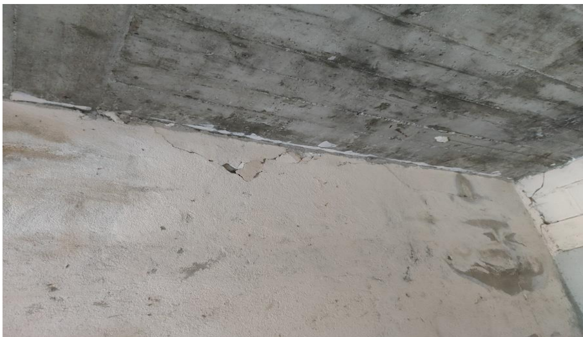
figura 24: grieta por pandeo-alabeo horizontal en el muro #5, generada por las fuerzas cortantes actuantes en su plano.
