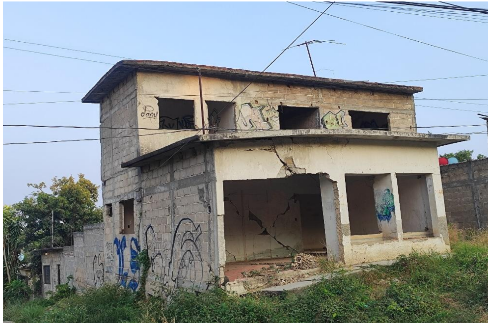
figura 25: vivienda con fallas ante esfuerzos cortantes, en elementos estructurales verticales y horizontales que se encuentran en el frente de la súper estructura
