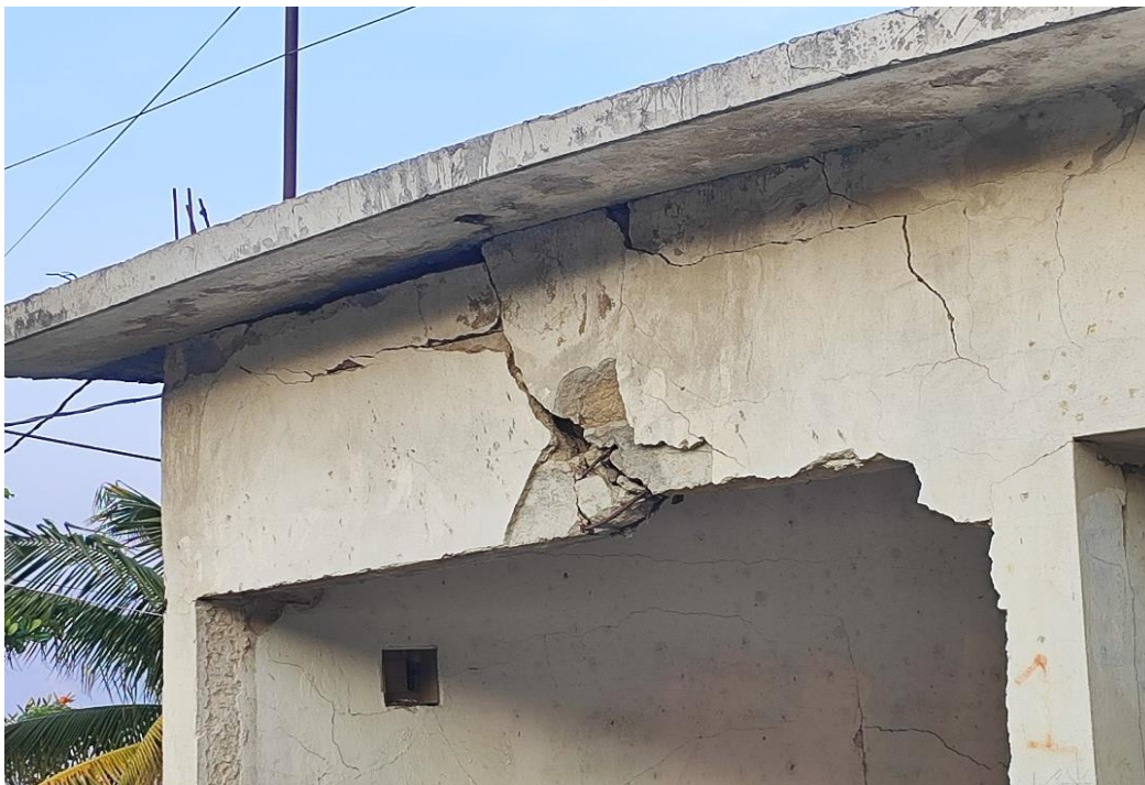
Figura 27: vista cercana del elemento estructural horizontal con grietas presente al frente de la vivienda, donde es altamente visible la deformación que se generó.
