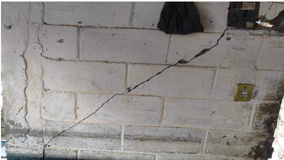
figura 23: diagonal de tensión presente en el muro #1, por fuerza cortante actuante en su plano, donde podemos observar un orificio que atraviesa el espesor del muro.
