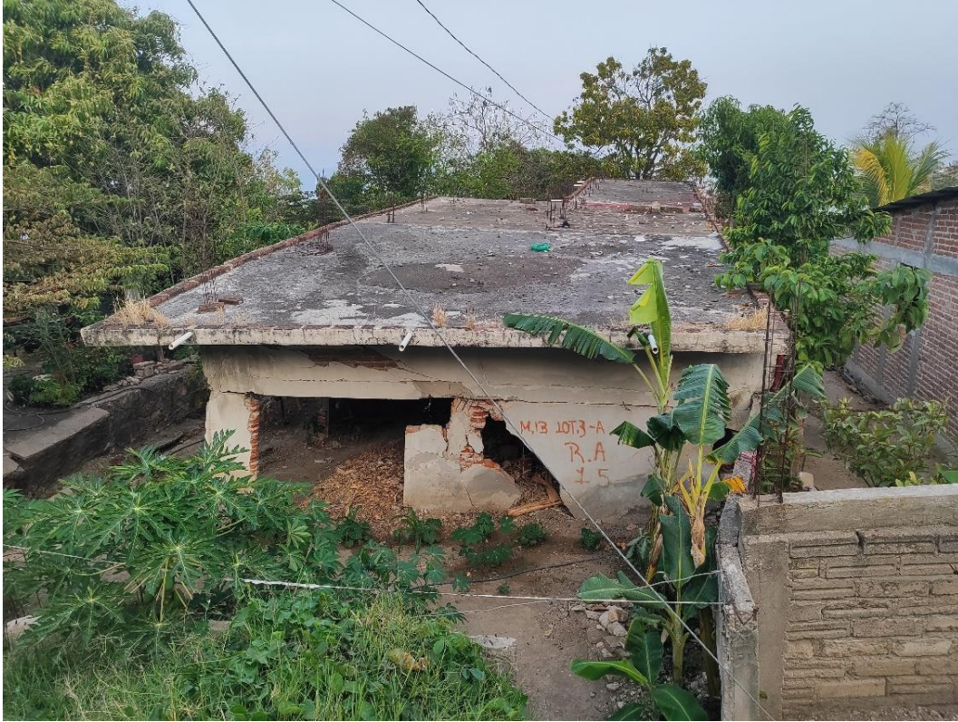
figura 29: vivienda con fallas ante el momento de volteo, que generó deformaciones en el sistema de piso y un desplazamiento lateral relativo exagerado, en un elemento estructural vertical ubicado paralelamente al centro de rigidez de la planta.
