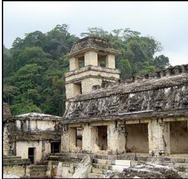
Figura 17. Casa C dentro del "Palacio".
