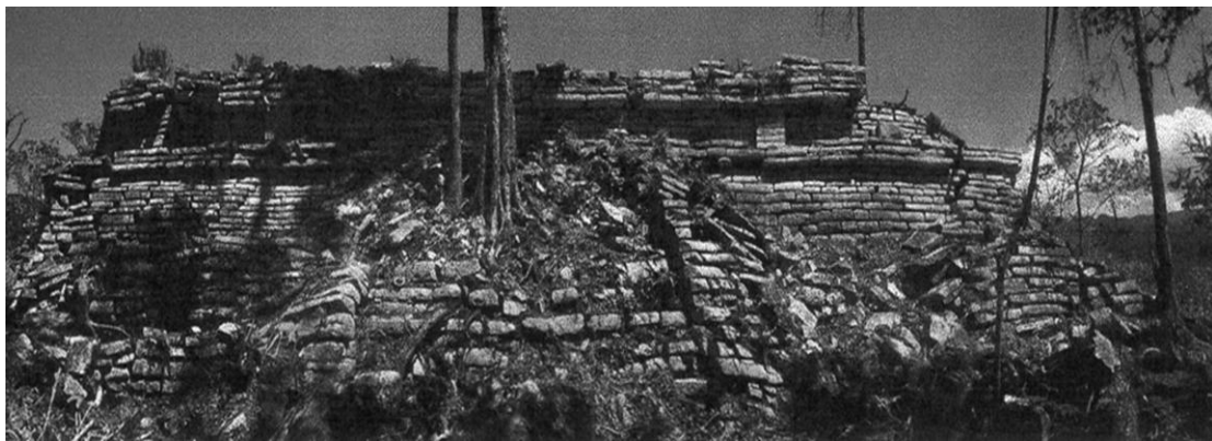
Figura 50. Vista general de la fachada principal de la estructura 1 de El Higo (Tomado de Domenici y Lee 2003).
