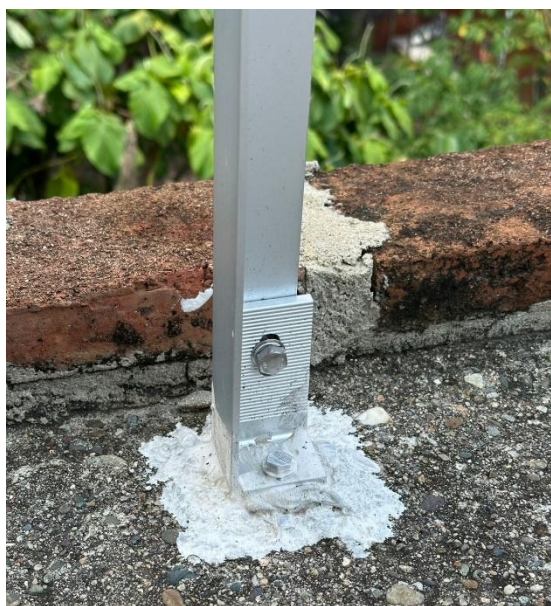
Ilustración 24: Base de la estructura.
