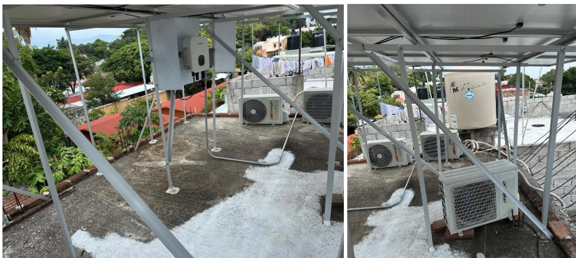
Ilustración 22: Refuerzos diagonales.
