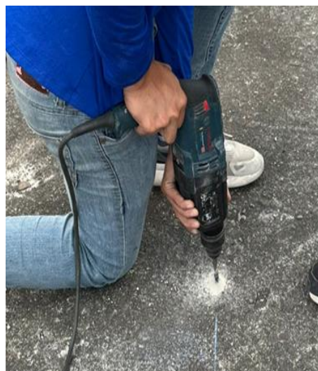
Ilustración 17: Medición del área de trabajo y perforación de la losa.
