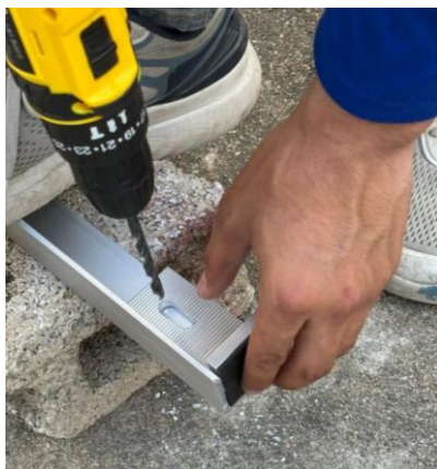
Ilustración 16: Perforación de los ángulos.
