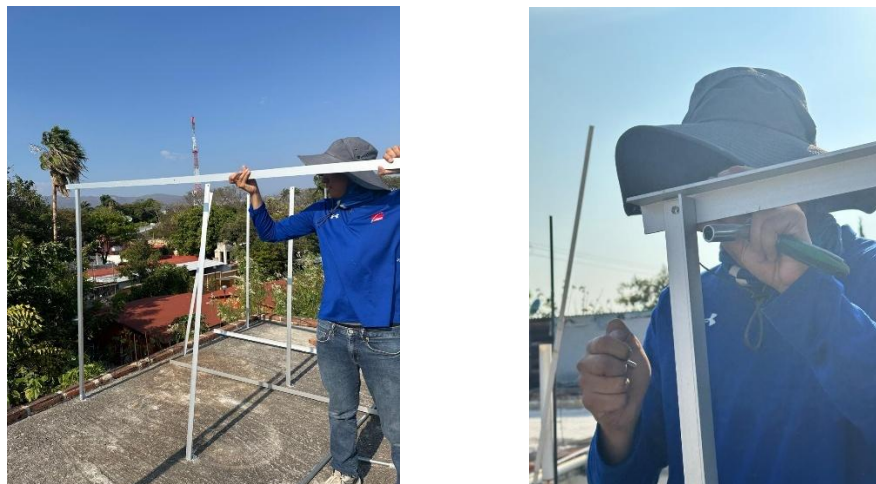
Ilustración 20: Montaje de las uniones laterales a los soportes estructurales.
