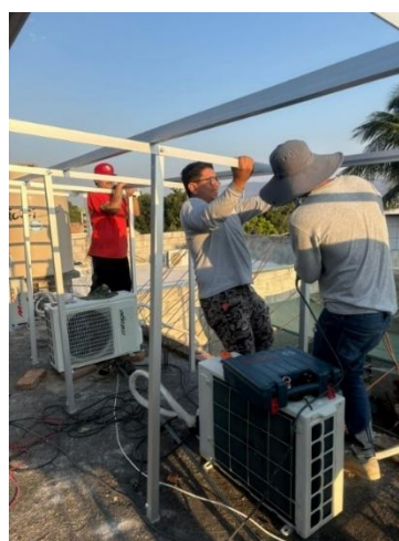
Ilustración 21: Sujeción de los rieles a la estructura de soporte.
