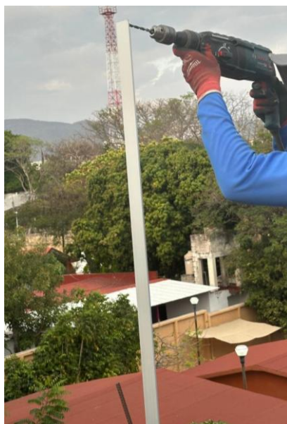
Ilustración 19: Perforación de los soportes estructurales.
