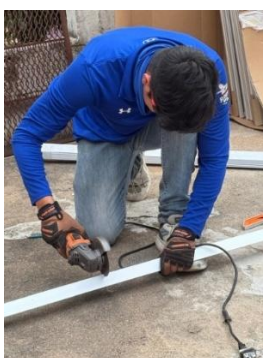
Ilustración 15: Corte de ángulos.
