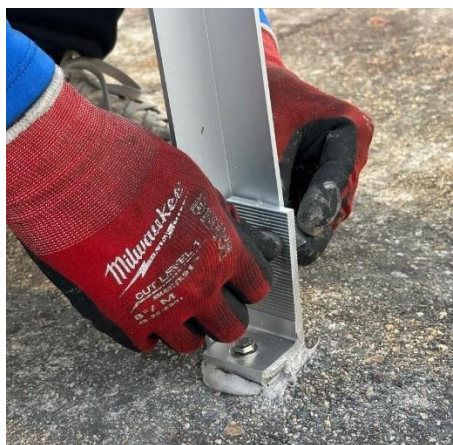
Ilustración 18: Anclaje de los L-Foot y ángulos.
