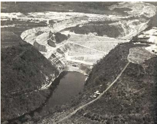
Imagen1. La Angostura en construcción, 1974
