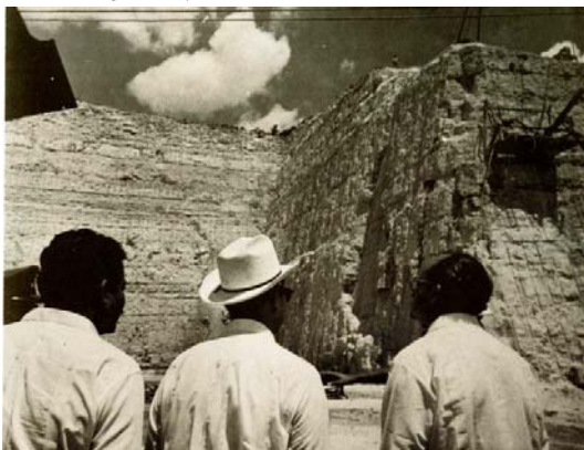
Imagen 3. En el lugar de la construcción de la represa La Angostura, el Sr. Presidente y el Sr. Gobernador analizan dicha obra en 1975
