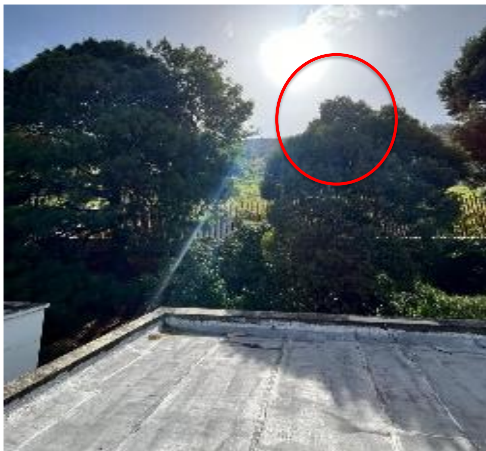
Figura 14. Proyección de sombras en el edificio Simón Bolívar.
