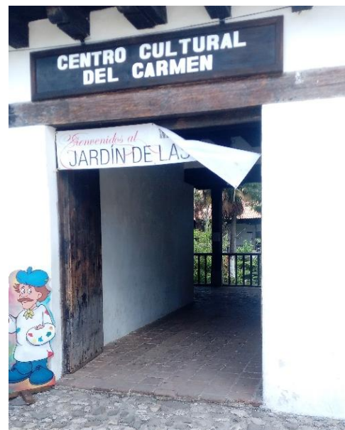
Figura 14 vista de la pared a intervenir desde el exterior del edificio.
