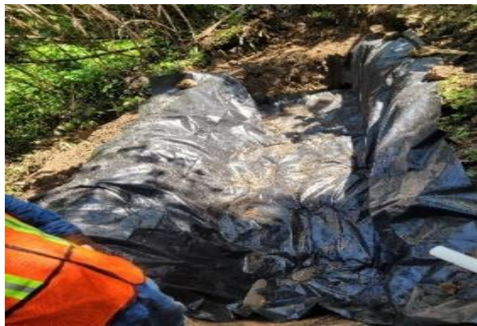
Figura 6. Colocación de impermeabilizante
