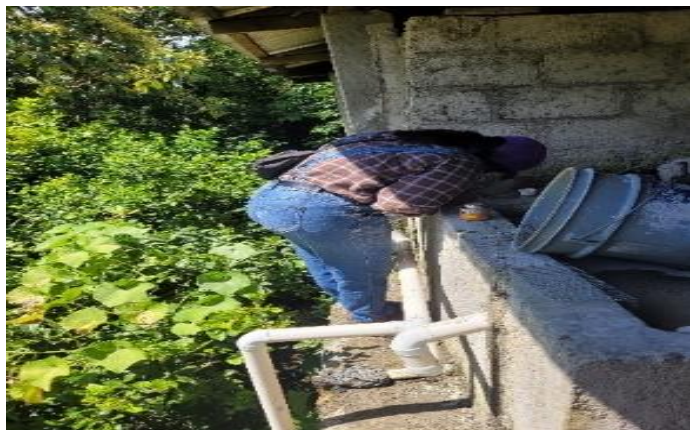
Figura 9. Instalación de tubería PVC
