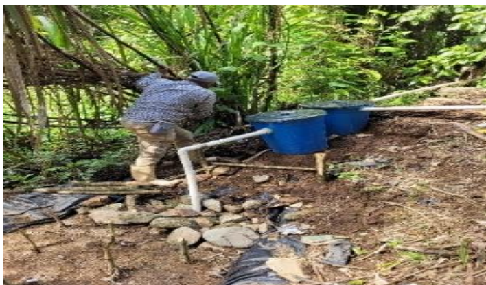
Figura 10. Instalación de recipientes de plásticos
