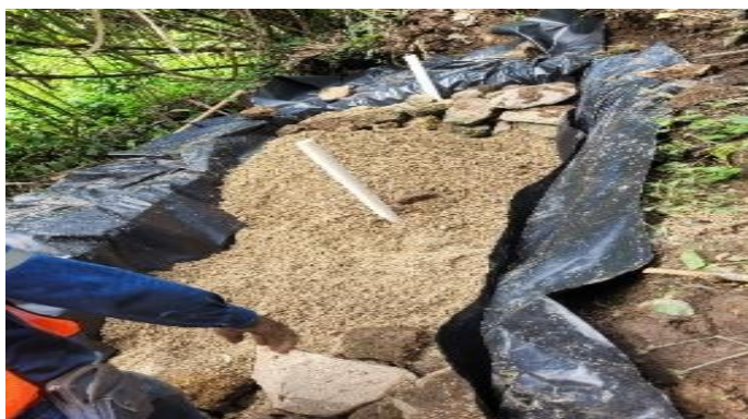
Figura 8. Incorporación de los materiales al humedal Fase 3
