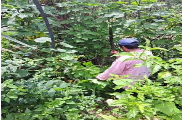
Figura3. Limpieza del área para la construcción del humedal
