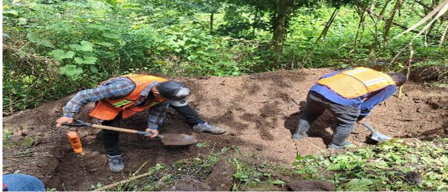
Figura .5. Excavación de la piscina para el humedal
