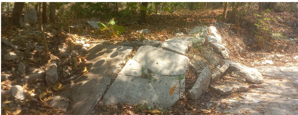
Figura 92. Banqueta con abultamientos de tierra en Calle Leopardo del Fraccionamiento (Foto: Lucero Jiménez, abril 2025).
