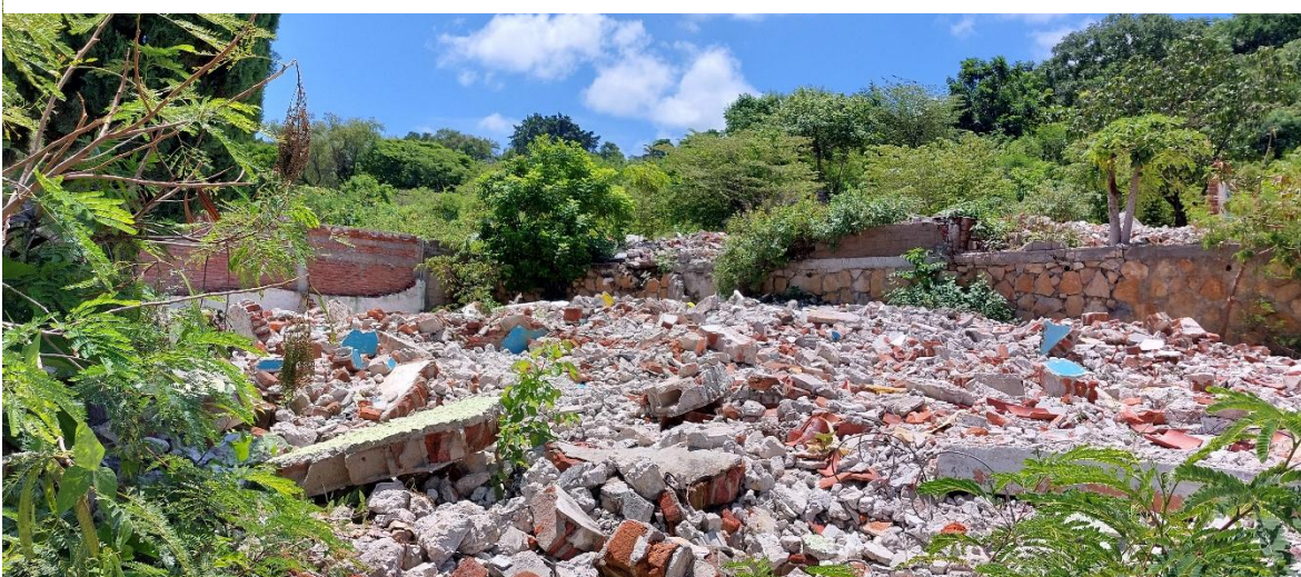
Figura 78. Demolición de viviendas en calle Puma en 2019 (Foto: Lucero Jiménez).
