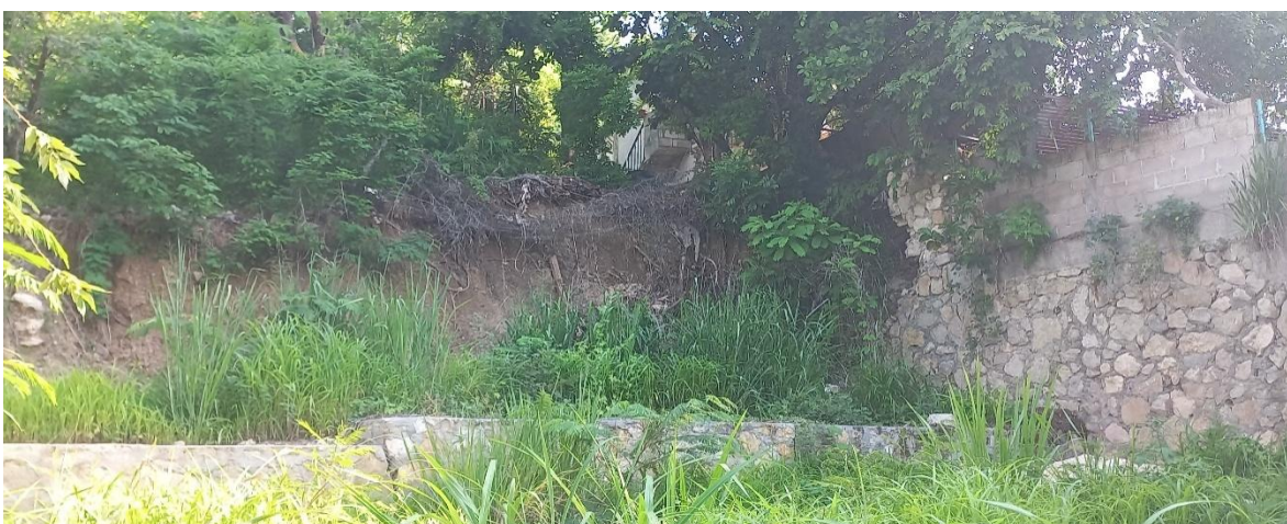
Figura 89. Talud y resto del muro de contención en calle Jaguar del Fraccionamiento La Cueva del Jaguar (Foto: Lucero Jiménez, julio 2024).
