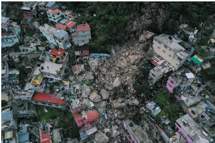
Figura 3. Derrumbes de rocas en el Cerro del Chiquihuite en el municipio de Tlanepantla (Fuentes, 2021).
