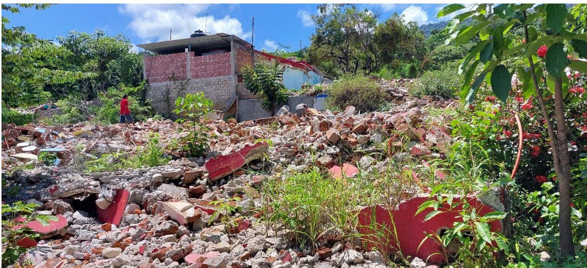
Figura 77. Demolición de viviendas en calle Leopardo en 2019 (Foto: Lucero Jiménez).
