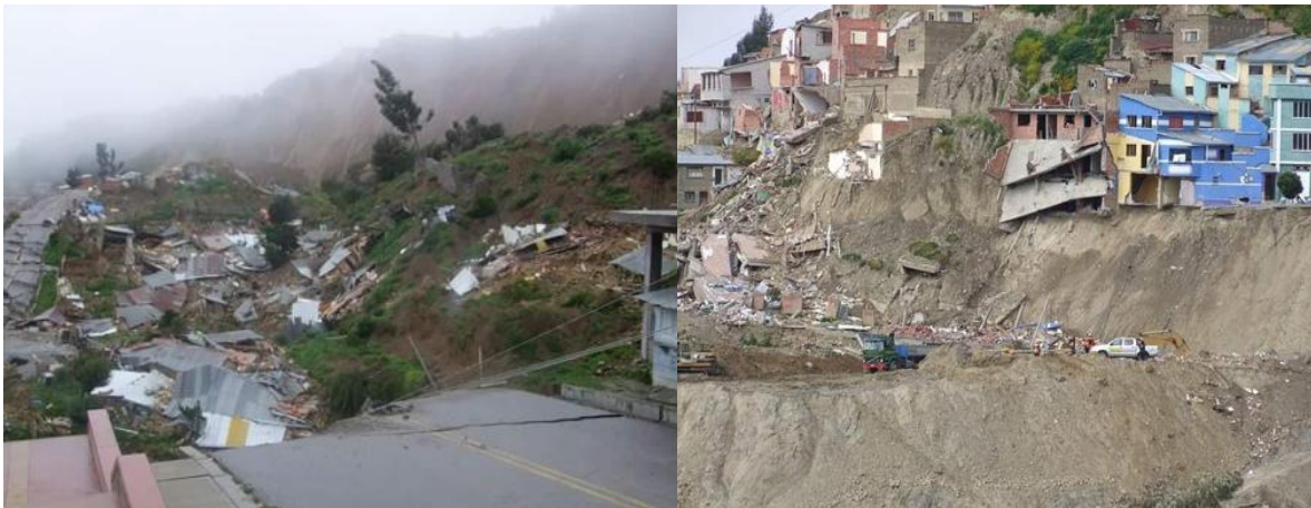
Figura 2. Deslizamiento activo en la ciudad de la Paz en Bolivia (Espinoza García & Llanos, 2017).
