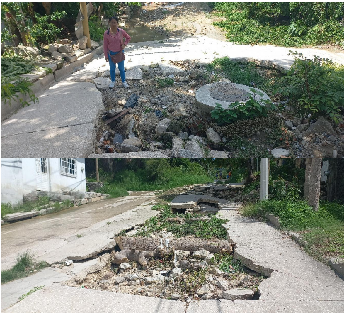
Figura 76. Pavimento destruido en Avenida Tacaná (Foto: Lucero Jiménez).
