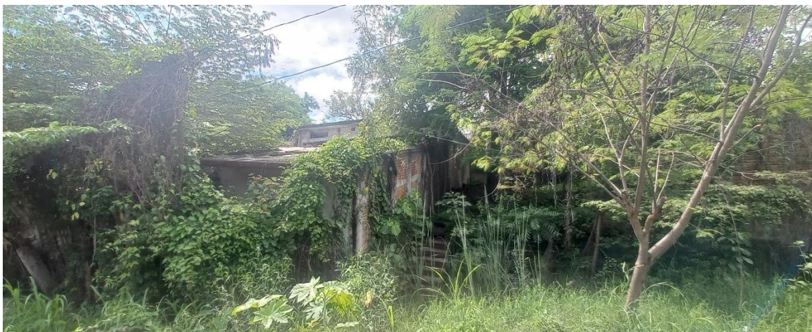
Figura 86. Casas muy dañadas cubiertas de vegetación en calle Lomas del encanto entre Loma Rica y Boulevard Loma Bonita (Foto: Lucero Jiménez, 2024).
